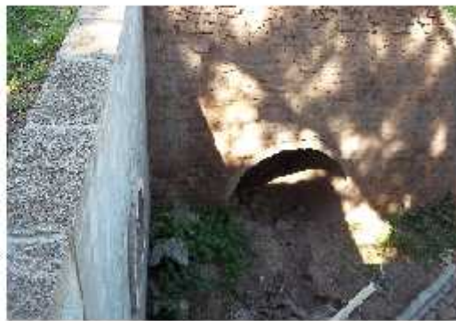
aguas abajo Alcantarilla IV
