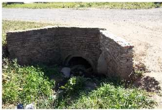
aguas arriba Alcantarilla IX
