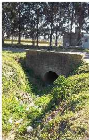
aguas arriba Alcantarilla IV
