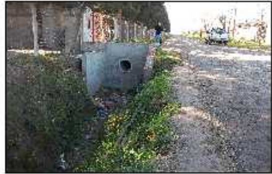
vista aguas arriba
