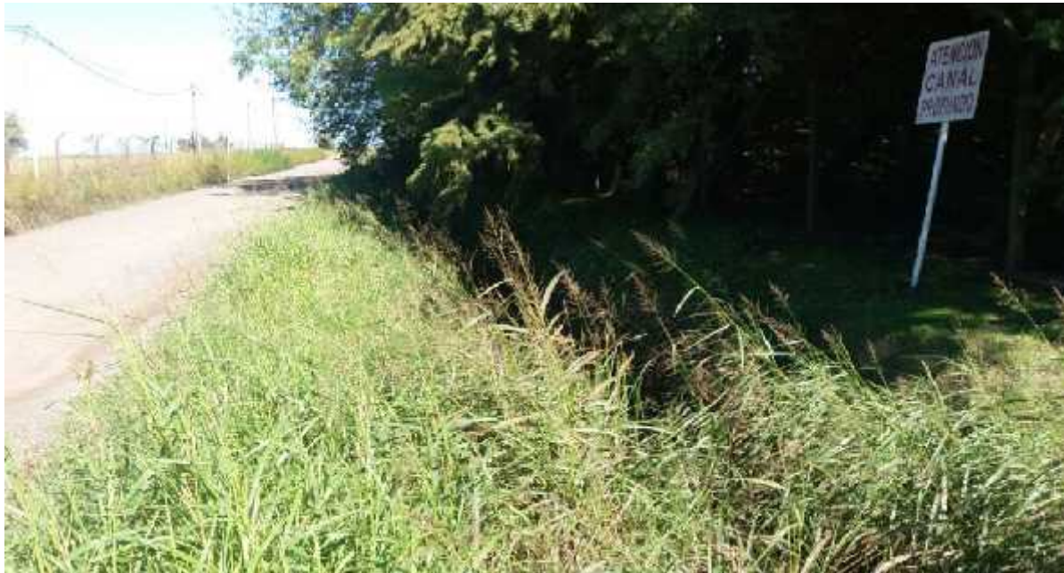
Canal Aliviador Existente - La Quemada
