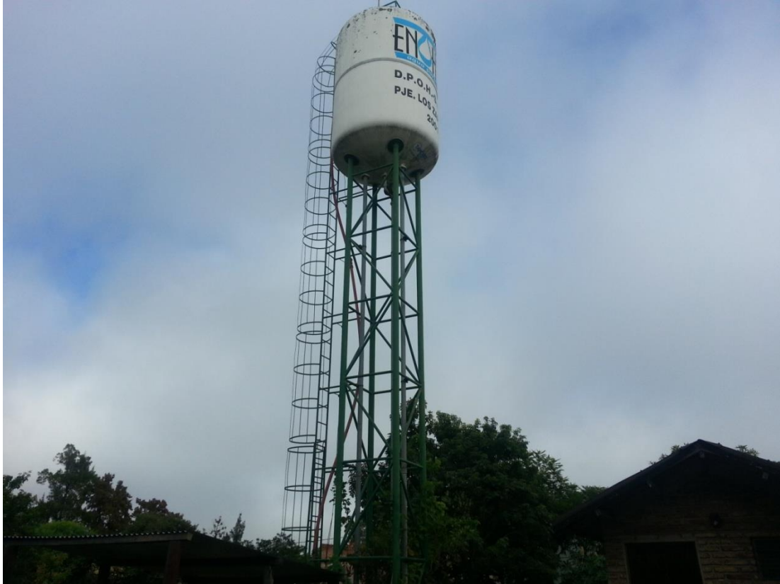
Ilustración 3-Vista Tanque elevado existente
