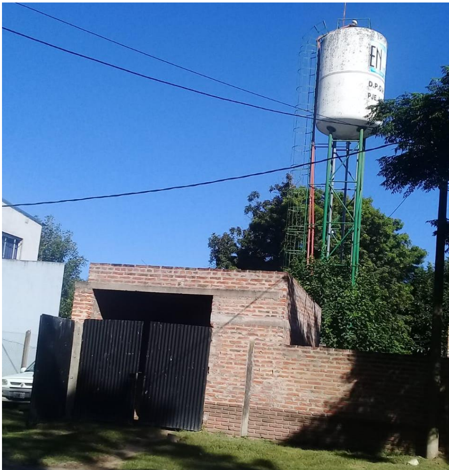
Ilustración 5 - Cerramiento frontal del predio del tanque elevado
