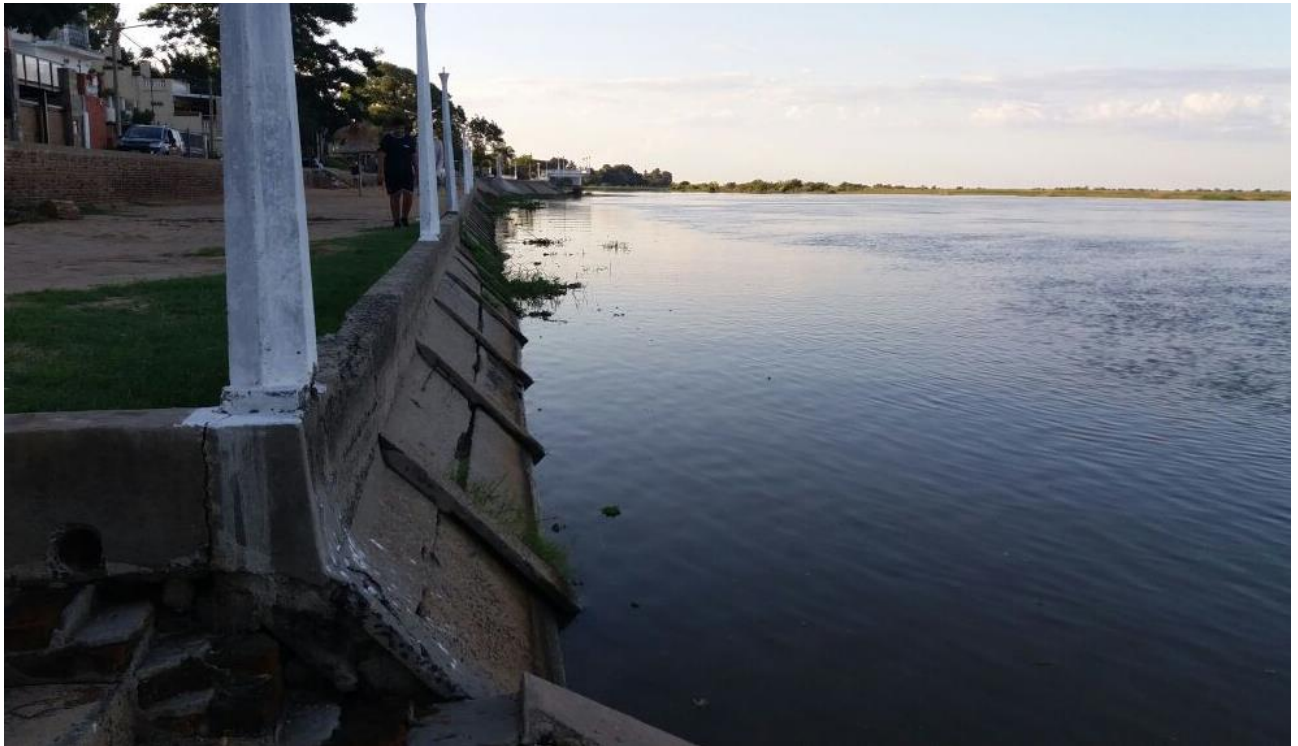
Zona descarga vista hacia el norte
