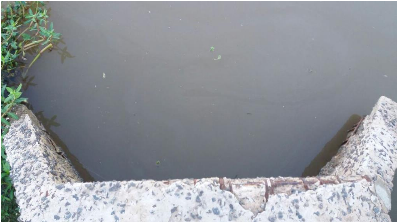
Descarga conducto existente
