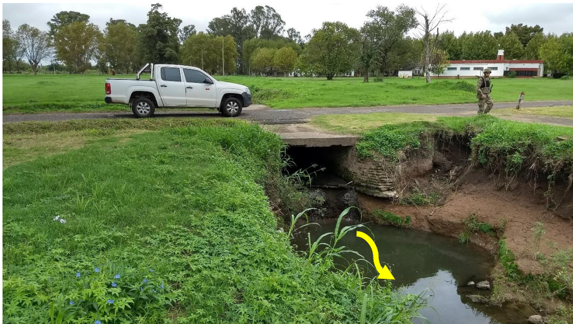
Canal en el Batallón. Alcantarilla 3 a reemplazar Vista desde aguas abajo
