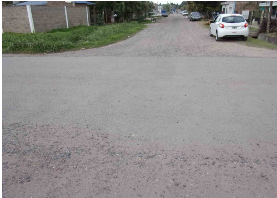
FOTO 6. CALLE LELEU: MEJORADO, ENRIPIADO, SIN CORDÓN CUNETA (CUNETAS REVESTIDAS DE HORMIGÓN, A AMBOS LADOS)
