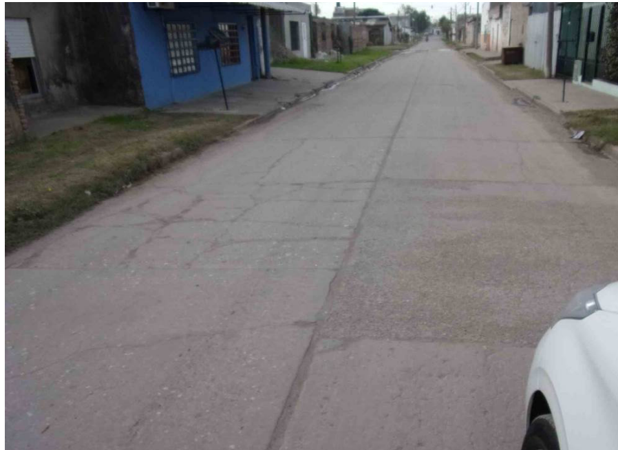
FOTO 4. CALLE GRAL. ARTIGAS (ENTRE RICCHERI Y FALUCHO): PAVIMENTO HORMIGÓN
