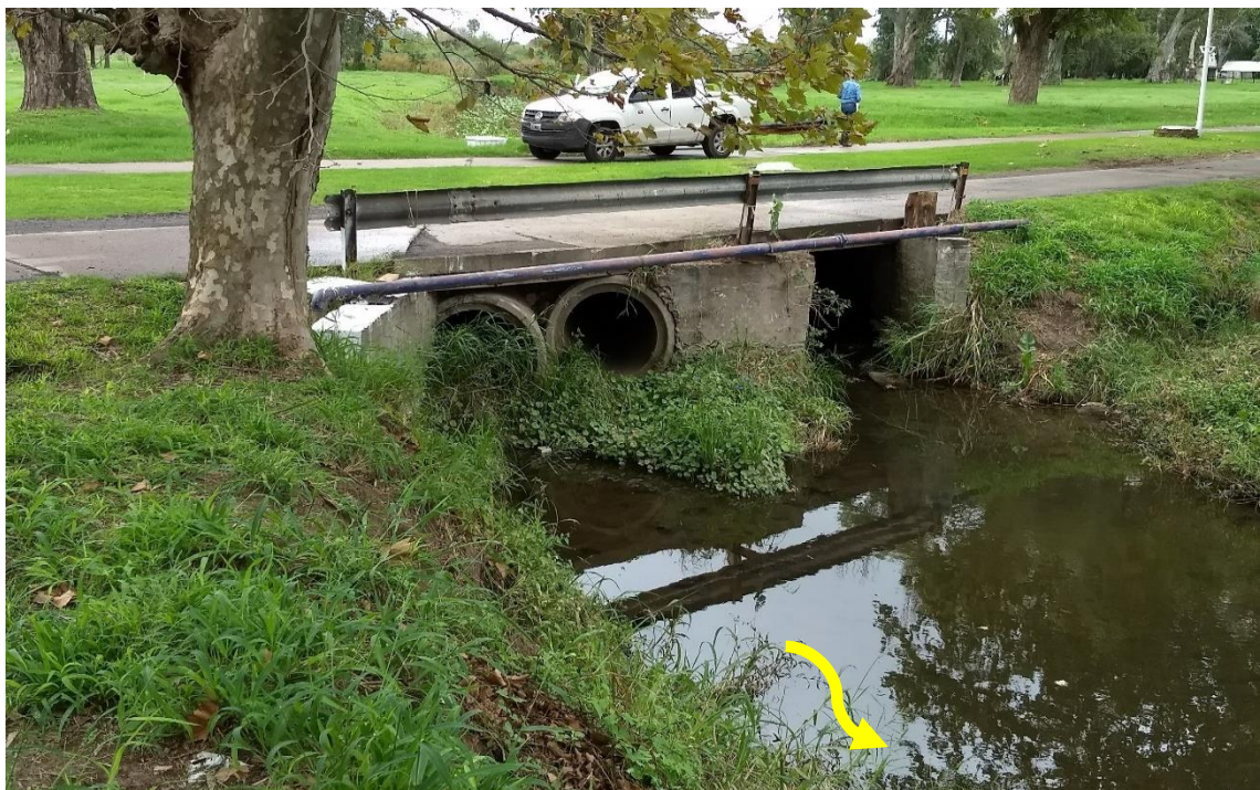
Canal en el Batallón. Alcantarilla 2 a reemplazar Vista desde aguas abajo
