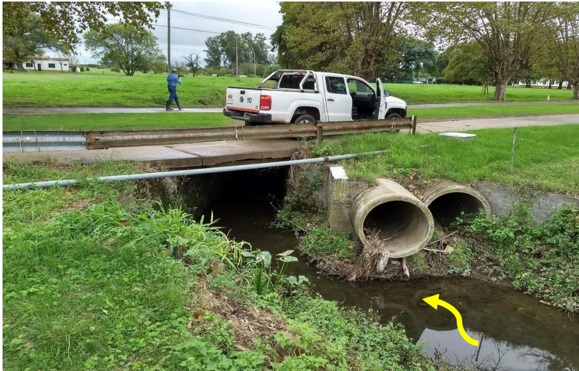
Canal en el Batallón. Alcantarilla 2 a reemplazar Vista desde aguas arriba
