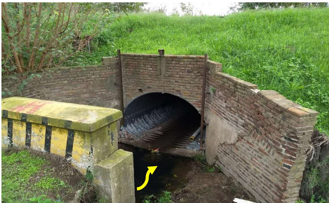
Vista alcantarilla transversal del FC Belgrano, desde Ruta Nac. N° 11, frente a alcantarilla anterior
