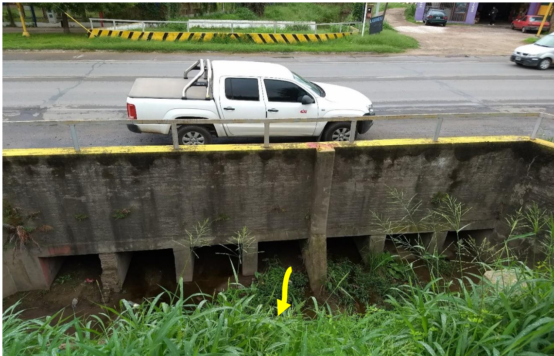
Vista del cruce del canal actual de la Ruta Nac. N° 11, desde el FC Belgrano
