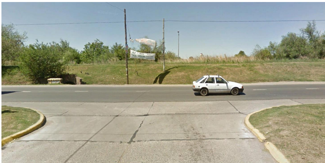
Vista de calle Gral. López y Ruta Nac. N° 11 Calle con pavimento de hormigón; asfáltica la ruta. Enfrente: el terraplén del FC Belgrano. A la izquierda: alcantarilla actual de cruce de la Ruta
