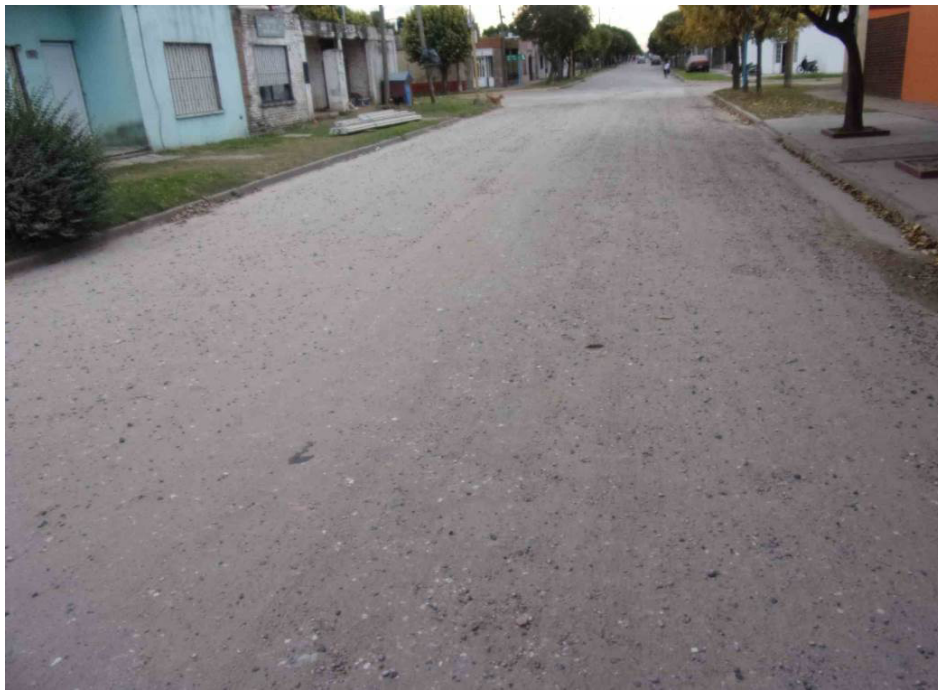
FOTO 8. CALLE SARMIENTO (ANTES DE GRAL. LÓPEZ): MEJORADO, ENRIPIADO, CON CORDÓN CUNETA
