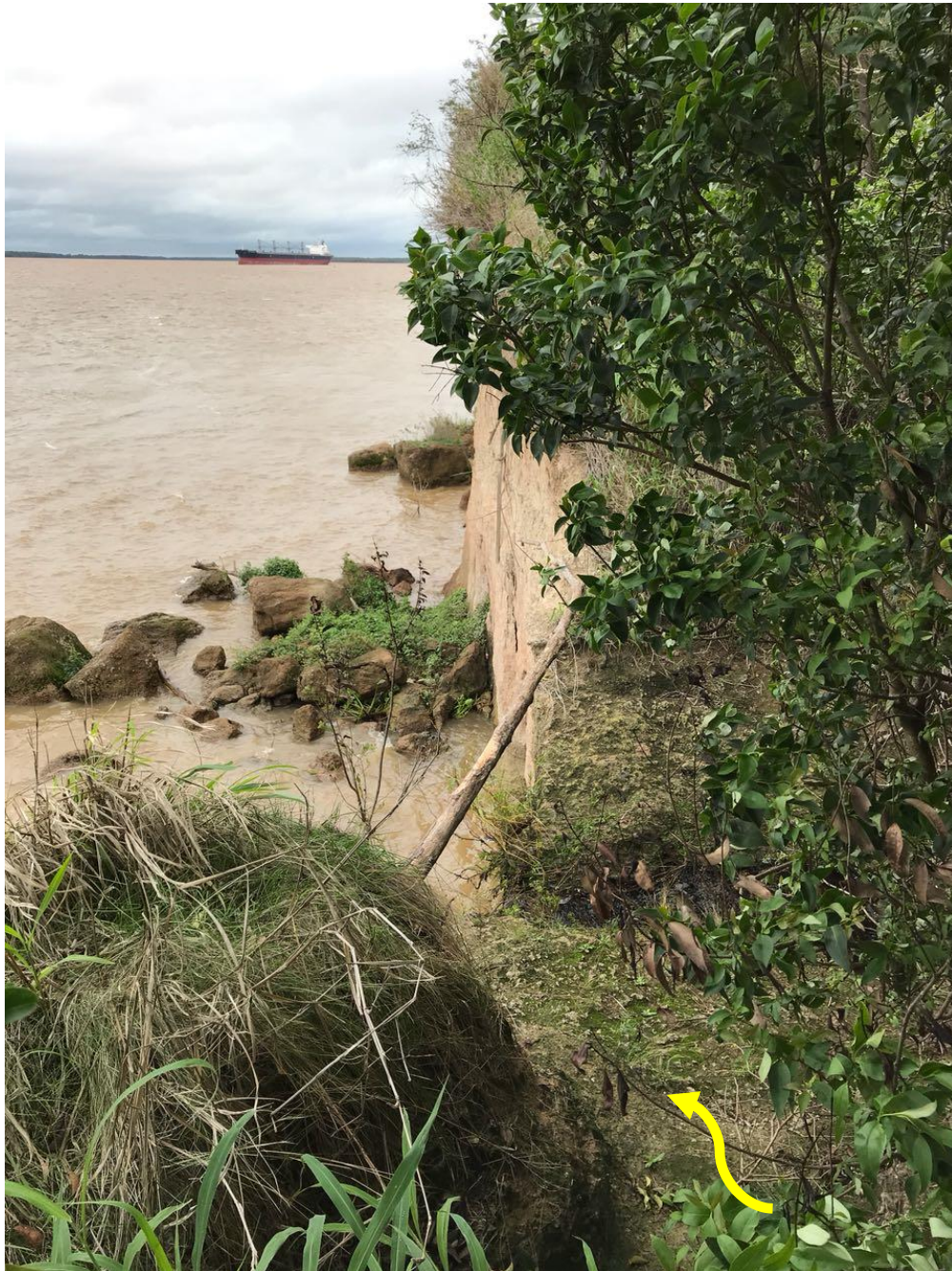
Canal en el Batallón. Llegada al río Paraná
