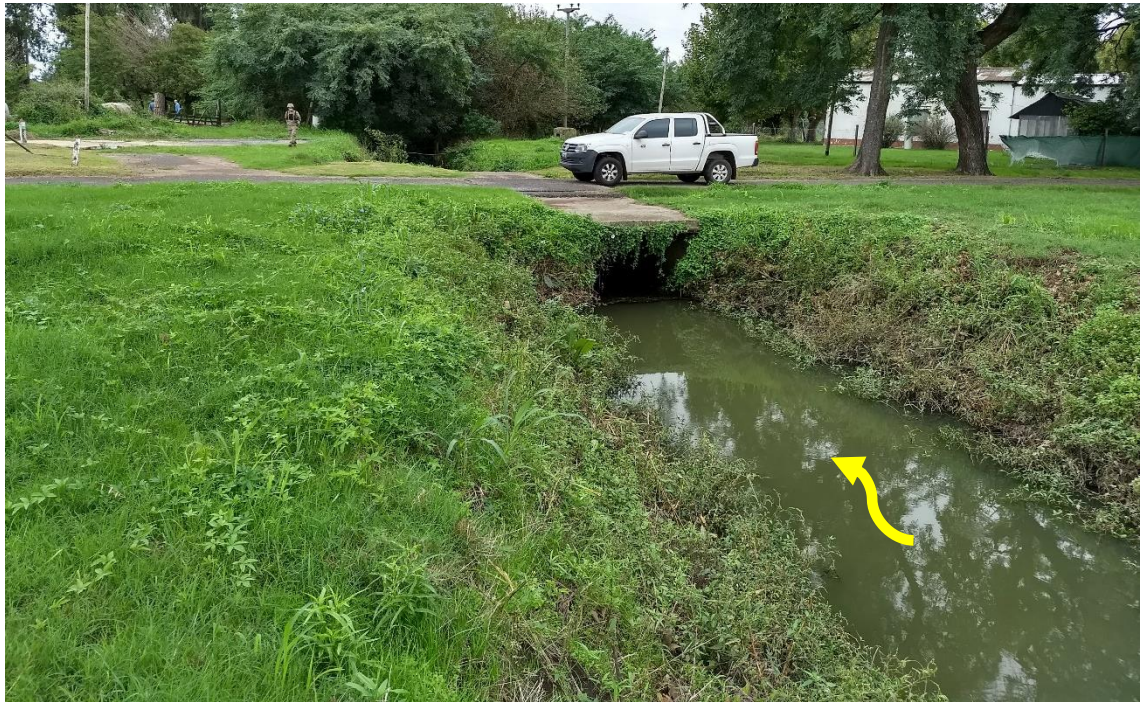
Canal en el Batallón. Alcantarilla 3 a reemplazar Vista desde aguas arriba
