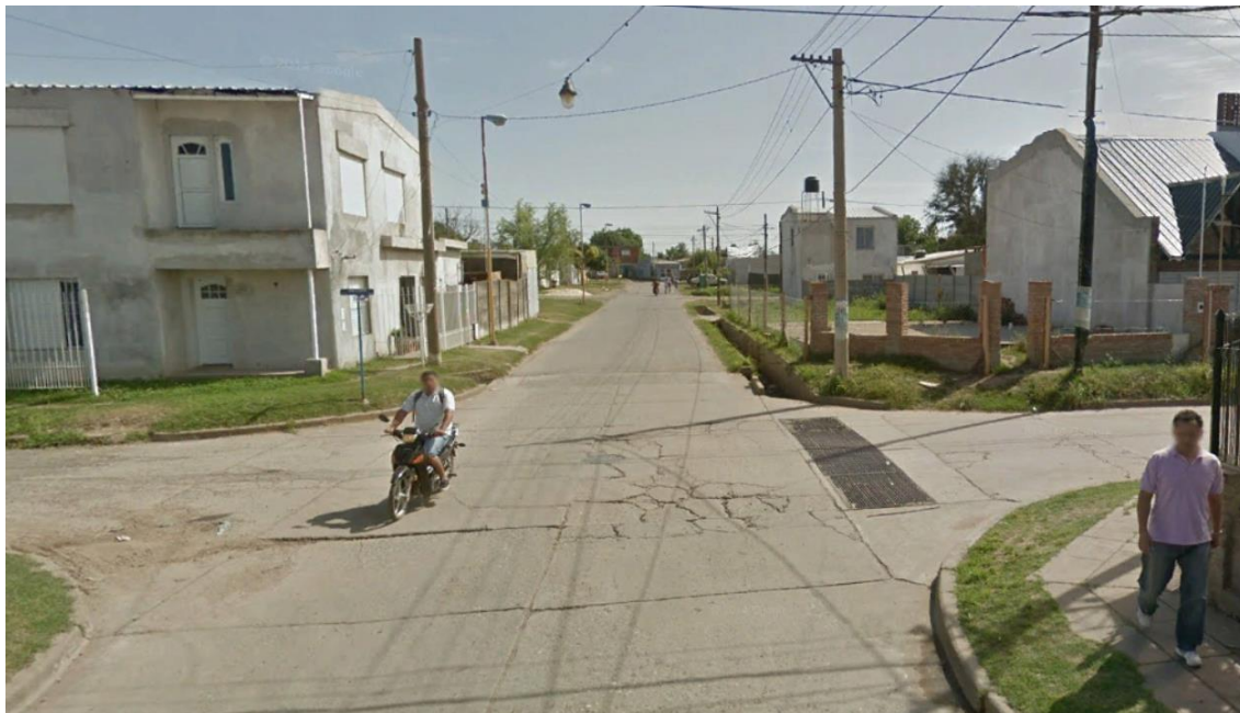
Vista de calle Gral. Artigas, desde Falucho hacia Leleu Calle con pavimento de asfáltico, sin cordones
