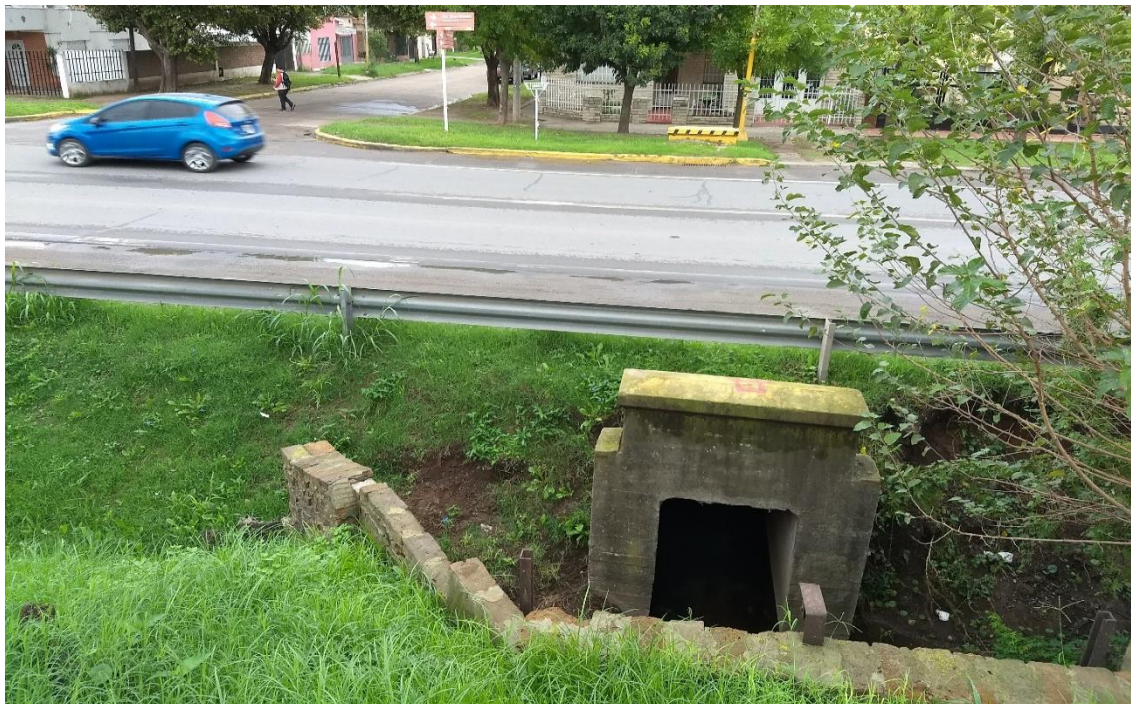
Vista alcantarilla transversal de la Ruta Nac. N° 11, desde el FC Belgrano A la Izquierda, la calle Gral. López
