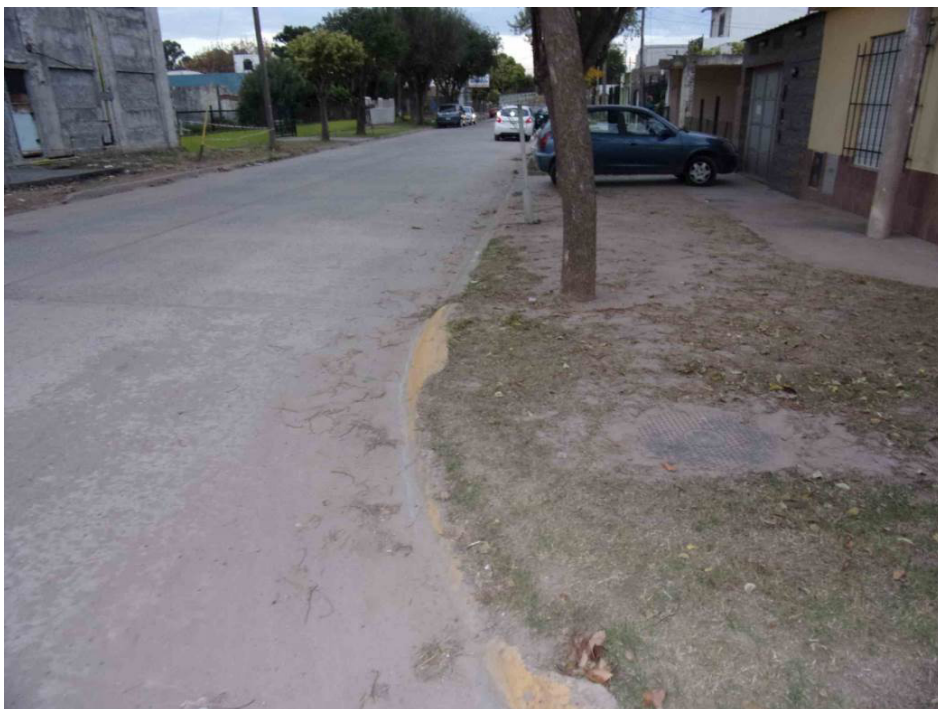
FOTO 9. CALLE GRAL. LÓPEZ (VISTA HACIA RN 11): PAVIMENTO DE HORMIGÓN, CON CORDÓN INTEGRADO
