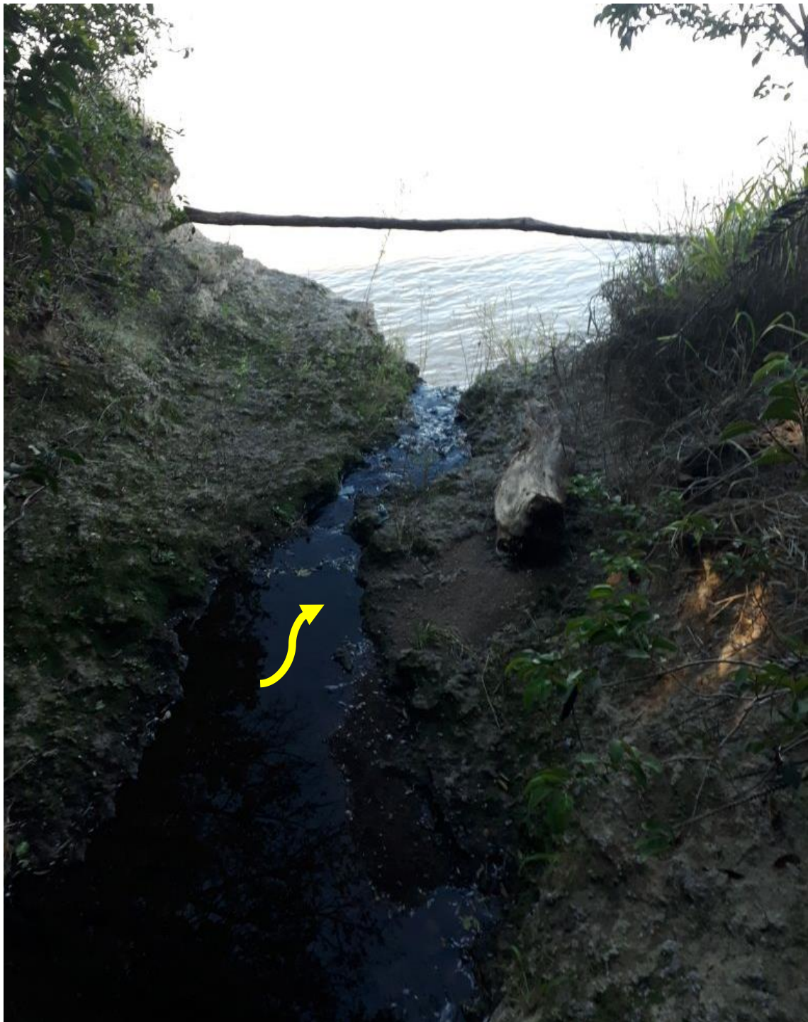
Canal en el Batallón. Llegada al río Paraná
