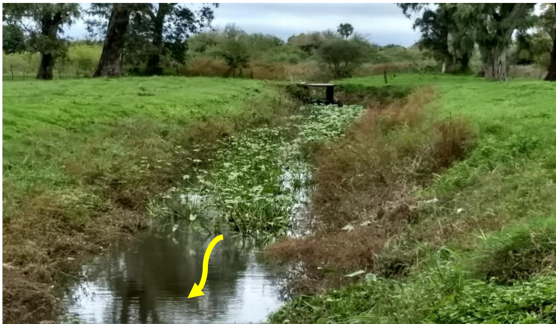
Canal en el Batallón. Alcantarilla 1 a reemplazar Vista desde aguas abajo
