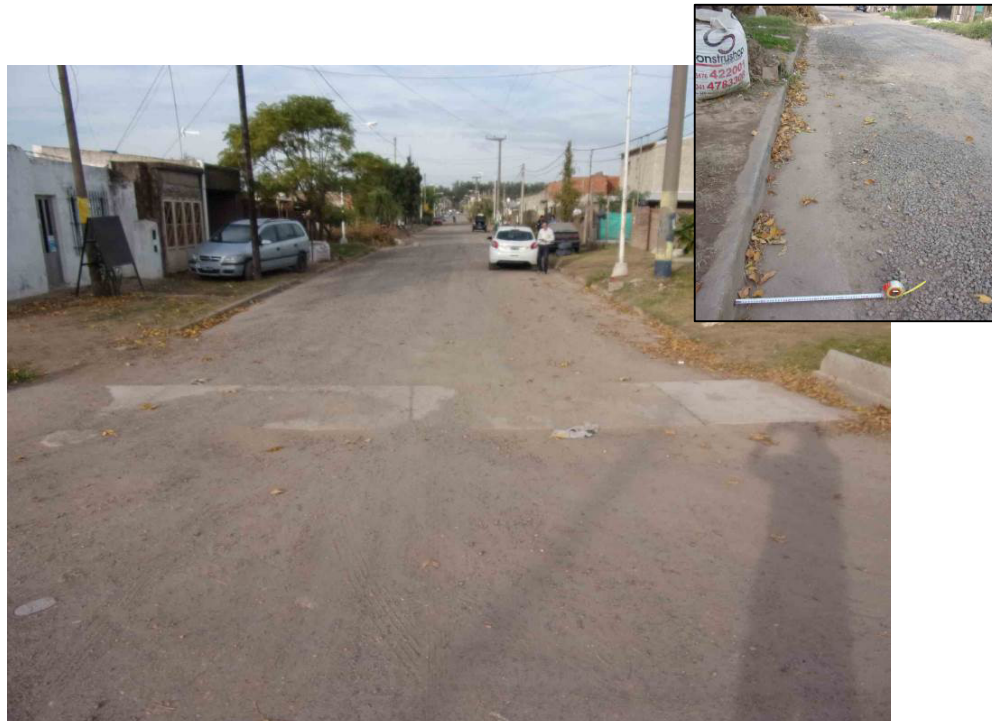
FOTO 3. CALLE RICCHERI: MEJORADO, ENRIPIADO, CON CORDÓN CUNETA
