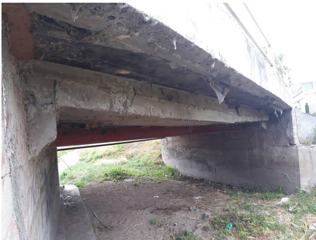
Imagen 36: Flecha del tablero
