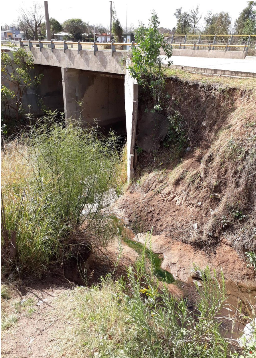
Imagen 25: Ala puente calle Güemes 10m lineales
