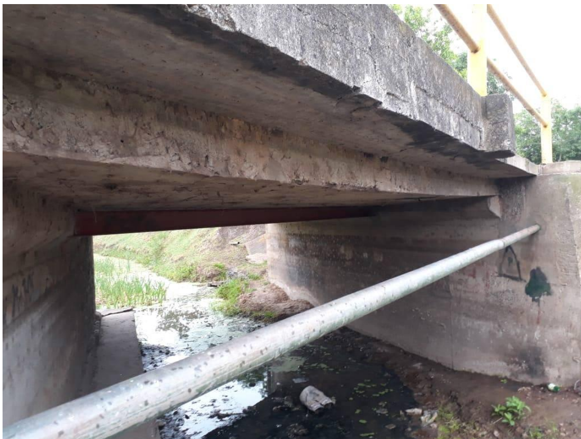
Imagen 37: Flecha del tablero
