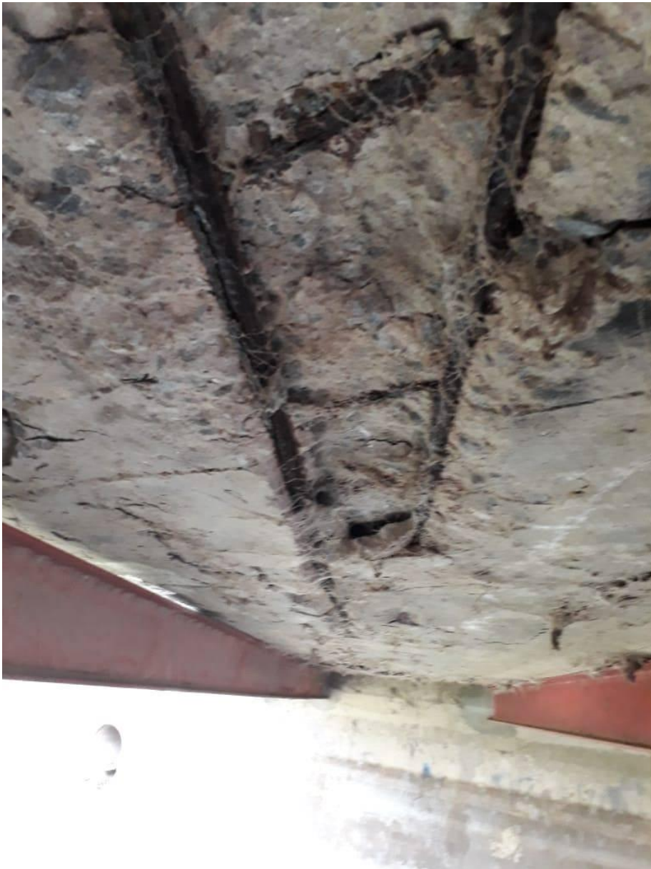
Imagen 39 Armadura expuesta
