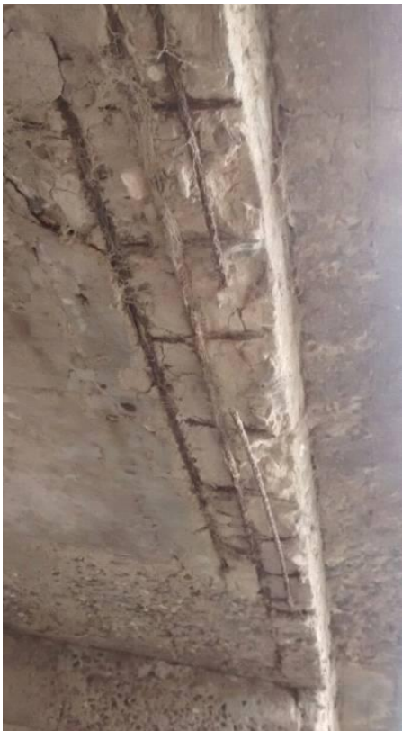
Imagen 27: Puente sobre calle Gabasio
