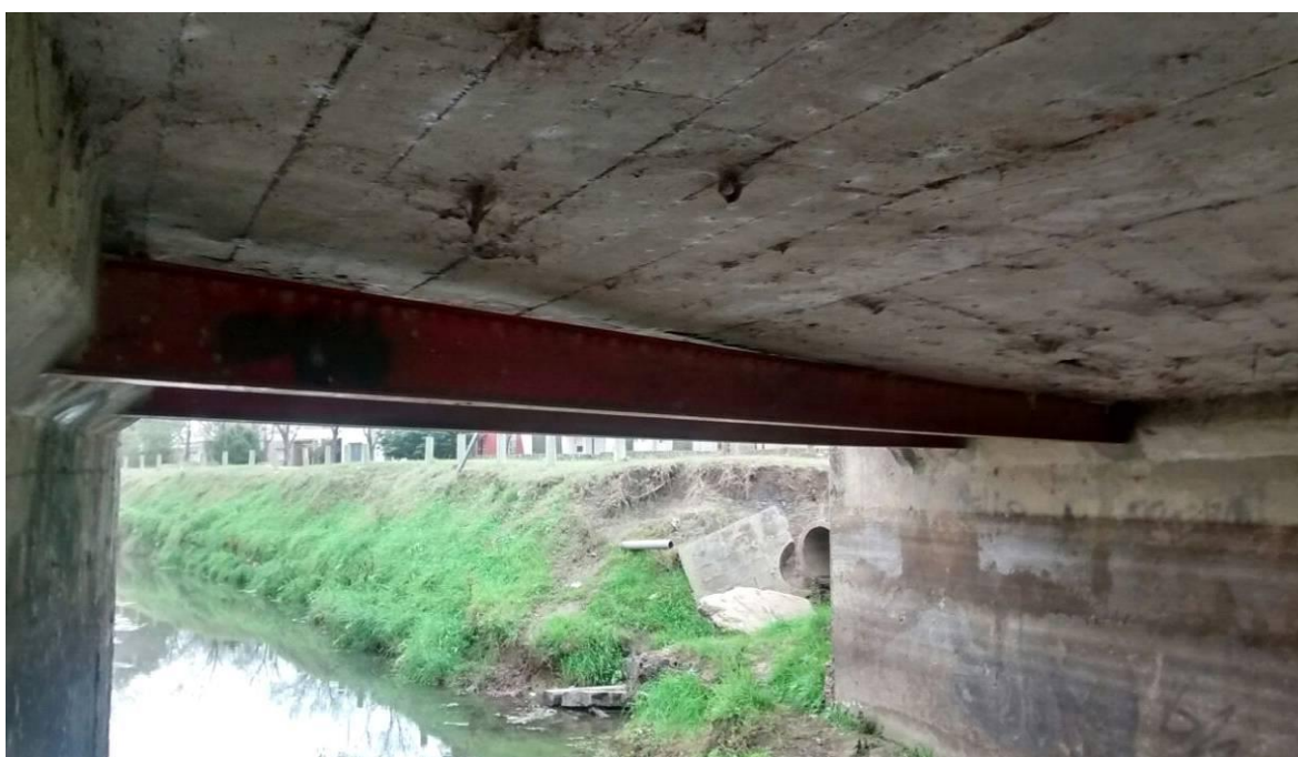
Imagen 34: Colocación de perfil metálico sobre Puente sobre calle Ameghino.
