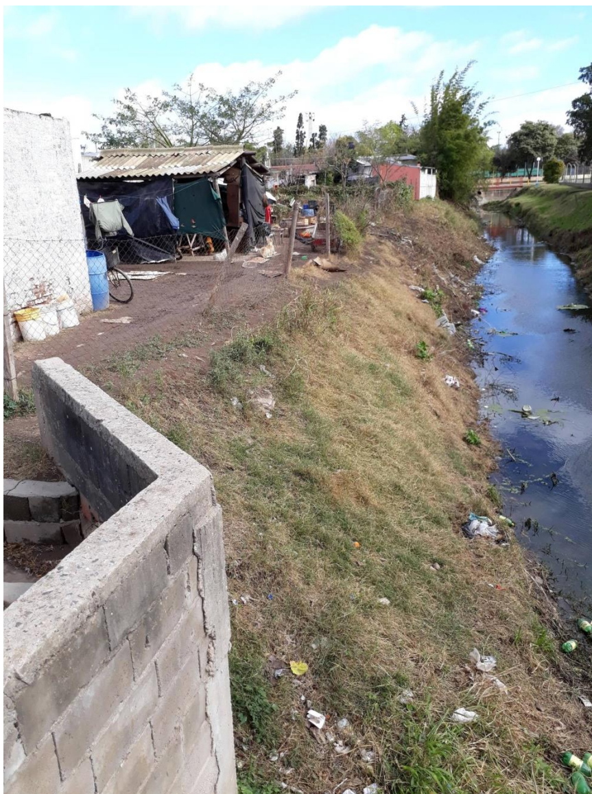
Imagen 18: Desagüe calle Leguizamon y curva del canal 80m lineales margen sur.
