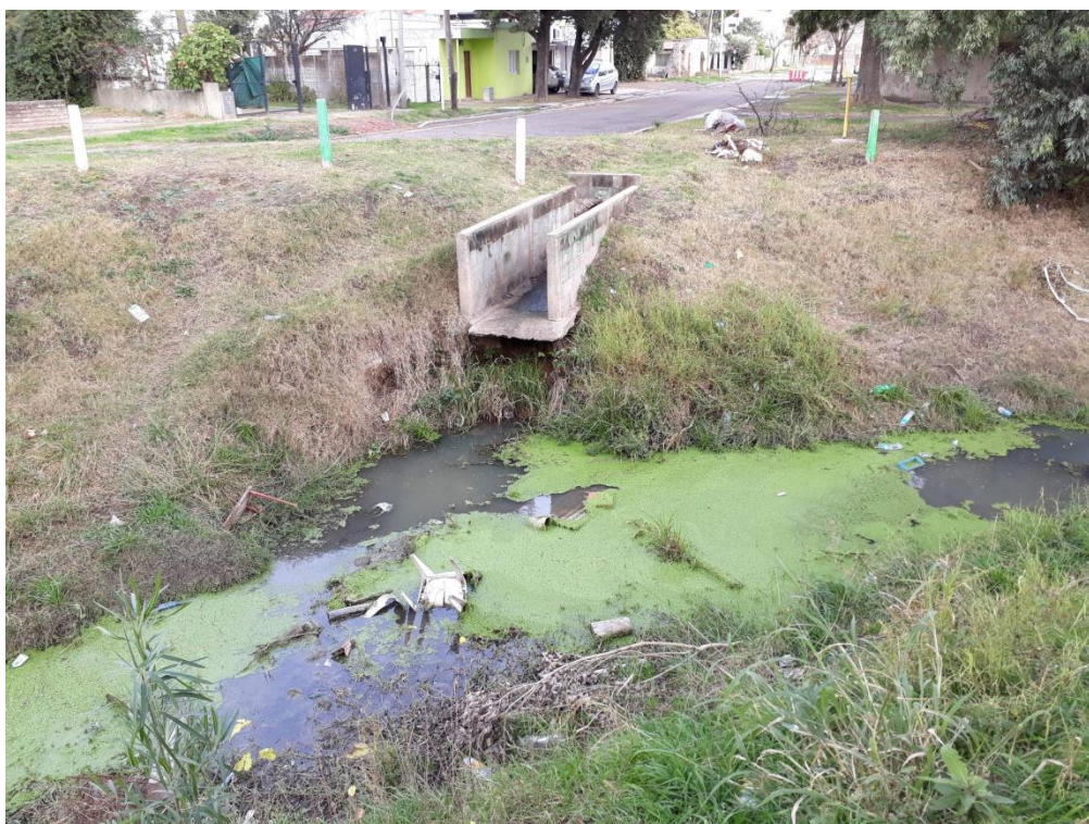
Imagen 12: Desagüe calle Entre Ríos 6 m lineales margen Sur.
