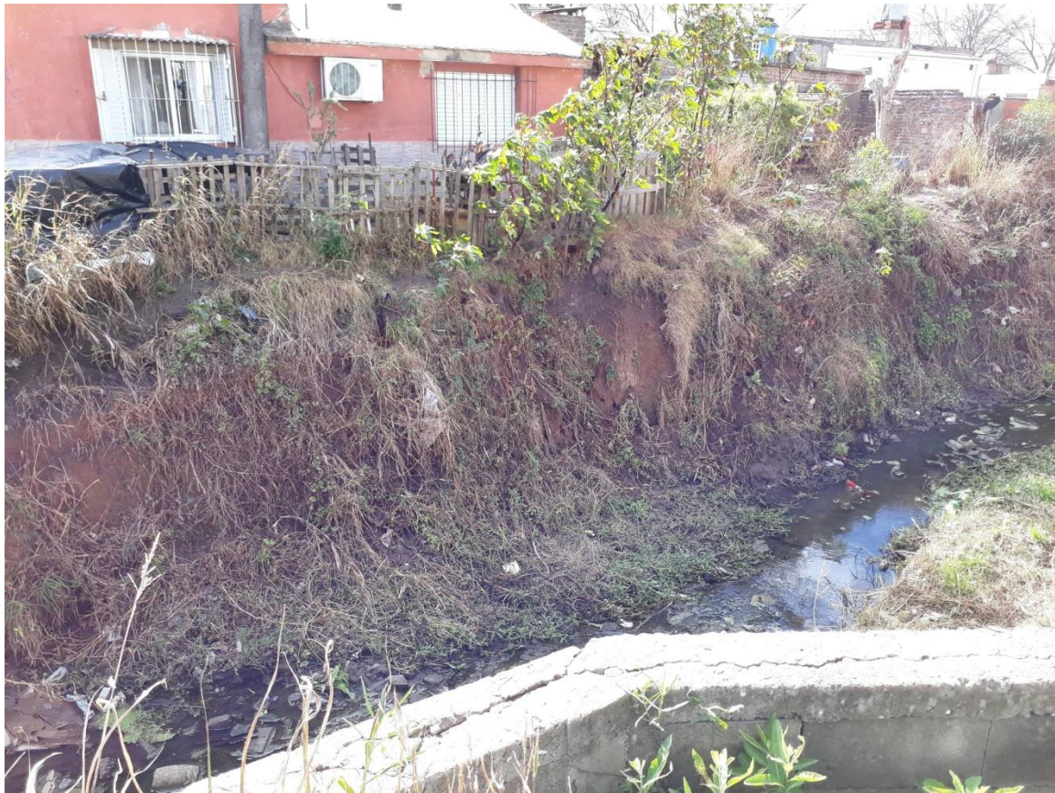
Imagen 19: Cortada Leguizamon 70m lineales margen Norte
