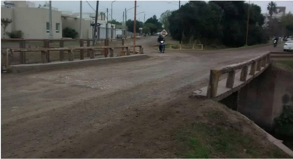
Imagen 26: Puente sobre calle Gabassio
