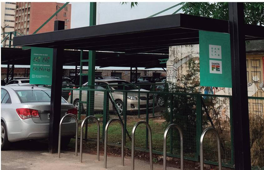
Las placas se deben colocar como muestra la imagen, una por columna y siempre perpendicular a estas.
