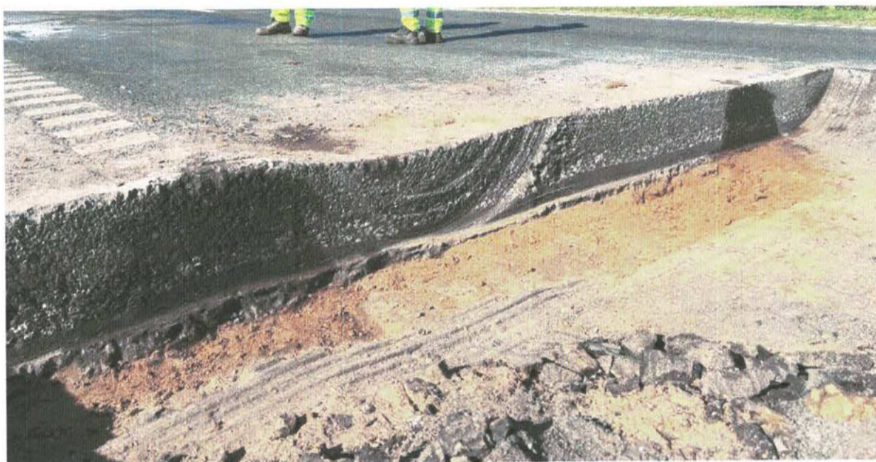
IMAGEN 8: Perfil transversal calicata
