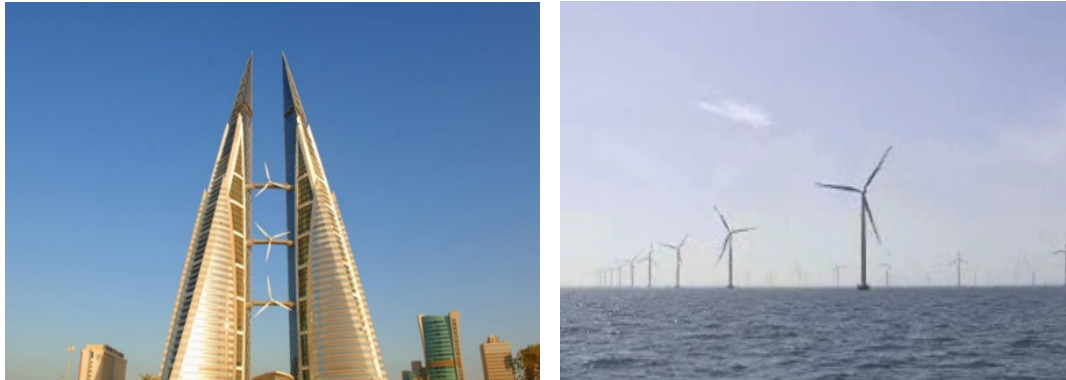
Figura VII: Ejemplos de aerogeneradores. Izq: Aerogeneradores incorporados a la estructura de un edificio (The Bahrain World Trade Center); Der: Parque eólico en el mar.
