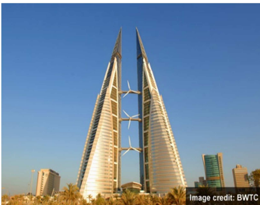
Ilustración 5: Ejemplos de aerogeneradores. Izq: Aerogeneradores incorporados a la estructura de un edificio (The Bahrain World Trade Center); Der: Parque eólico en el mar.
