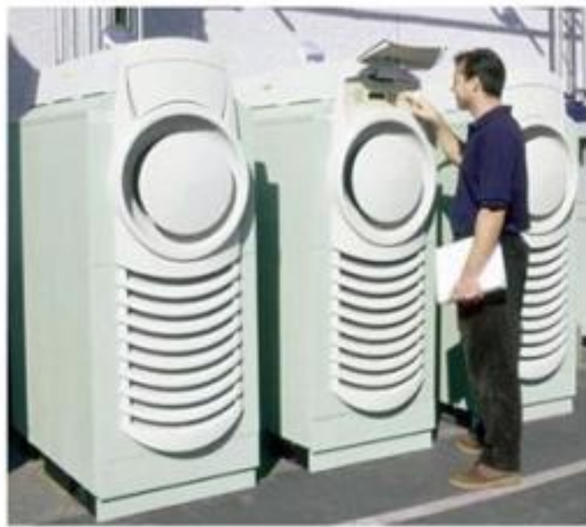
Ejemplo de 3 microturbinas trabajando en paralelo.
