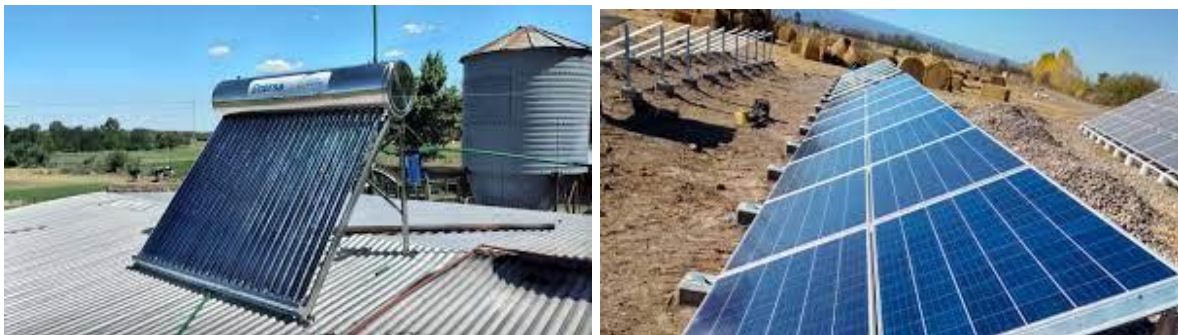
Figuras 19 y 20: Ejemplo de instalaciones solares (sistema solar térmico compacto - termotanque solar- a la izquierda y paneles fotovoltaicos a la derecha)
