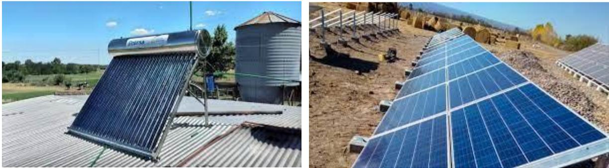
*Figura 13: Ejemplo de instalaciones solares (sistema solar térmico compacto - termotanque solar- a la izquierda y paneles fotovoltaicos a la derecha)*
