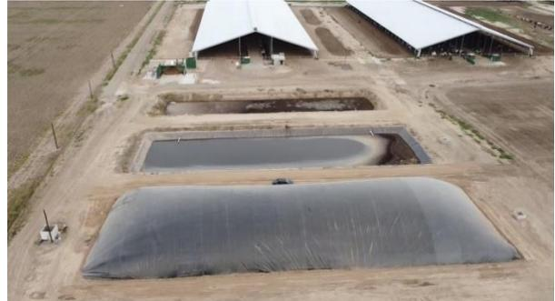
*Figura 15: Biodigester de flujo continuo (izq) y de laguna cubierta (der)*
