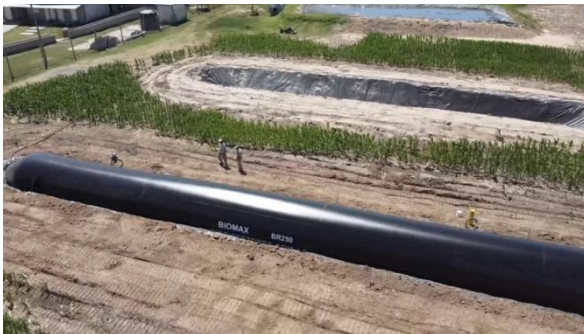
Figura 9: Biodigestor de flujo continuo (izq) y de laguna cubierta (der)
