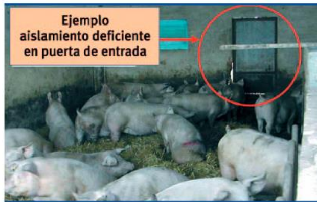
Figura 2: Ejemplo aislamiento deficiente en instalación ganadera
