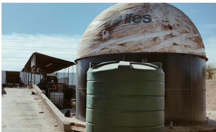
Figura 10: Biodigestor de mezcla completa
