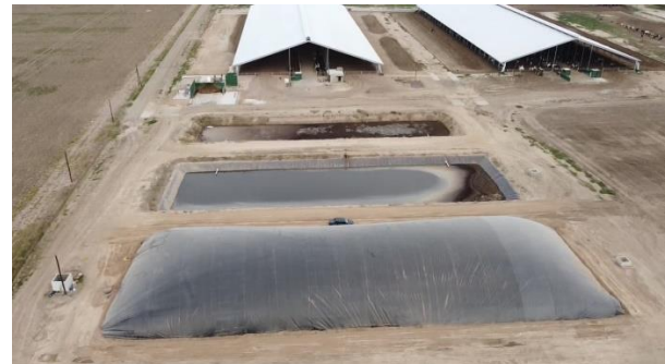
Figura 9: Biodigestor de flujo continuo (izq) y de laguna cubierta (der)
