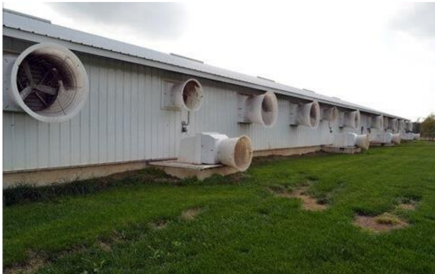
Figura 4: Ejemplo de un sistema de ventilación en una granja porcina
