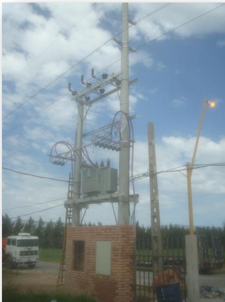
Acometida en Baja Tensión – 380 V
