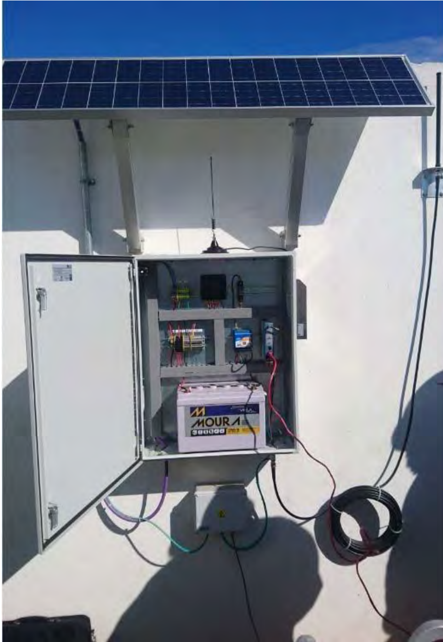
Fig. 2 – Imagen ejemplo instalación
