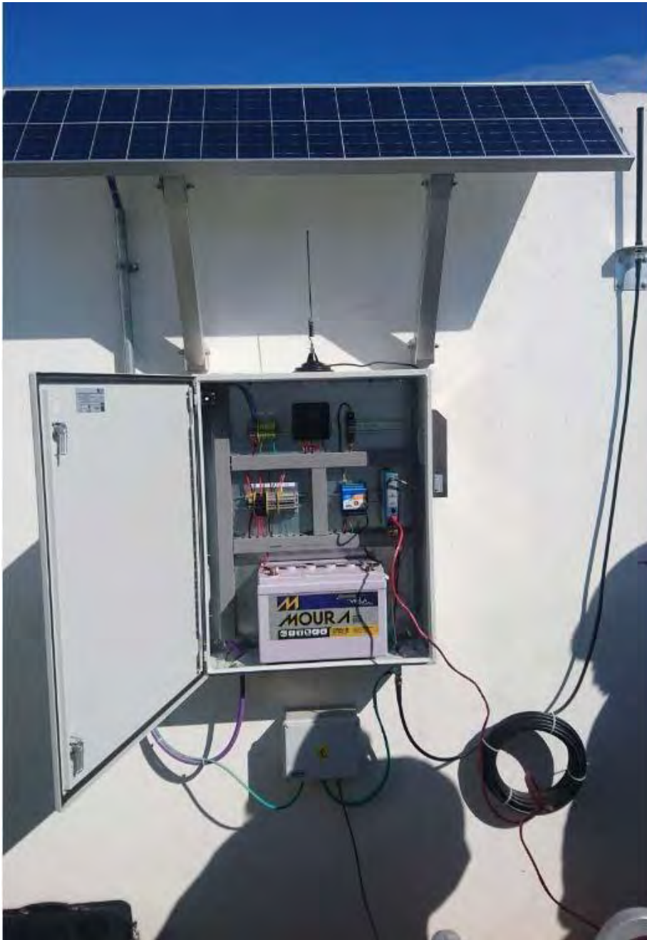
Fig. 2 – Imagen ejemplo instalación
