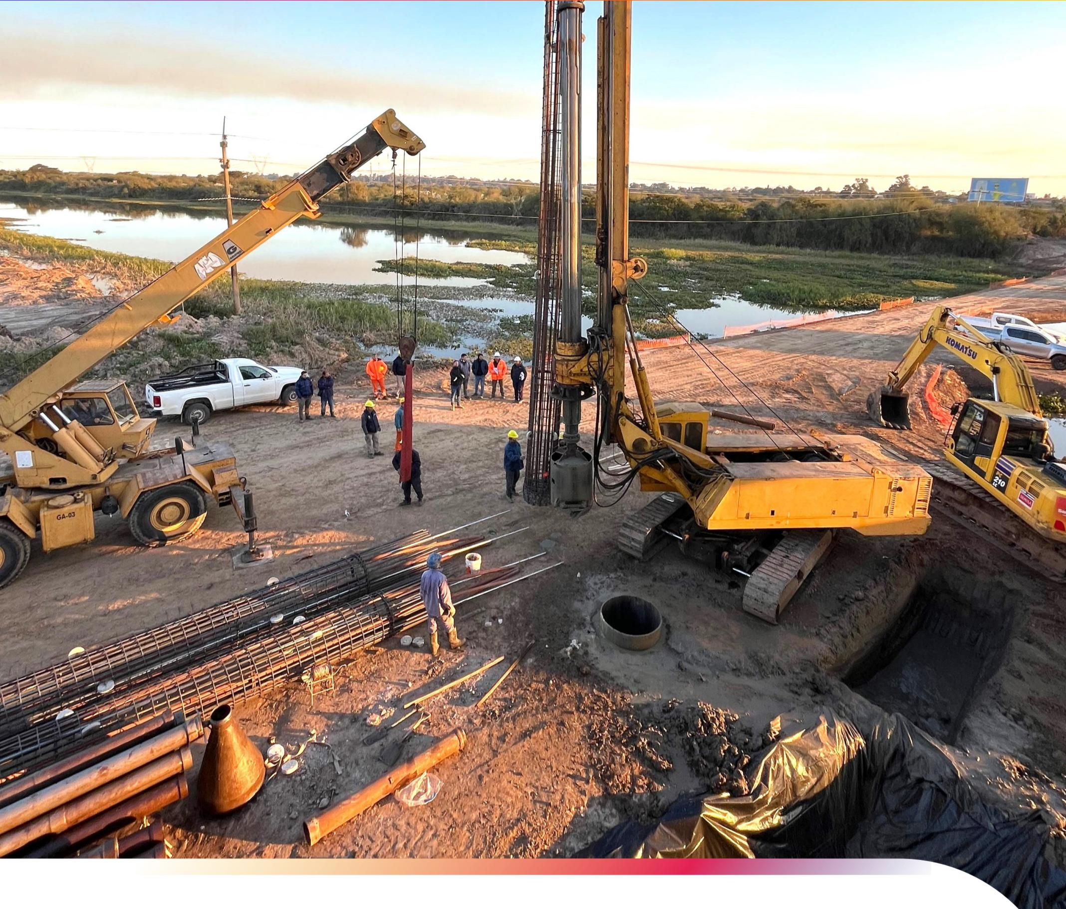
**Incorporamos armaduras metálicas y tuberías que sirven para posteriormente inyectar la celda de precarga. Esto nos permite ejecutar ensayos no destructivos para la verificación de la continuidad del hormigón del pilote.**
