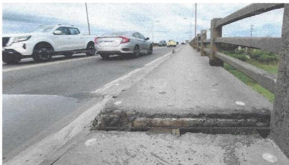
Figura 5. Rotura en las juntas
