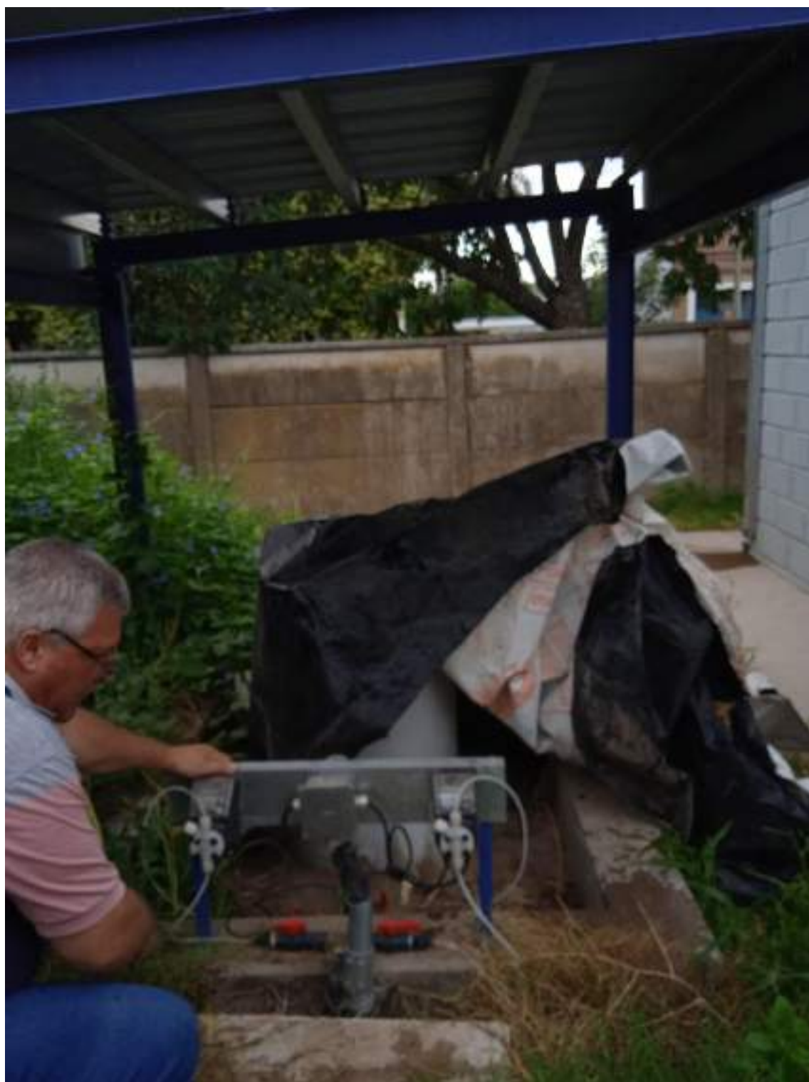
Foto N° 3: Sala de Cloración existente con dos bombas dosificadoras, con sus correspondientes tanques
