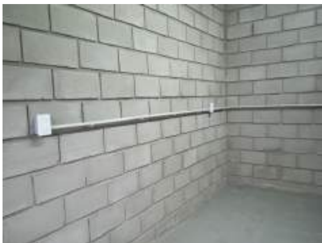
Foto N° 6: Paredes internas con instalación eléctrica – Casa Química
