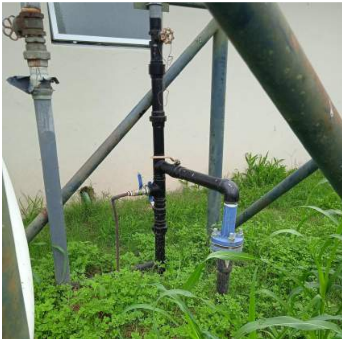
Foto N° 8: Cañería tanque elevado existente conectada a cañería Acueducto
