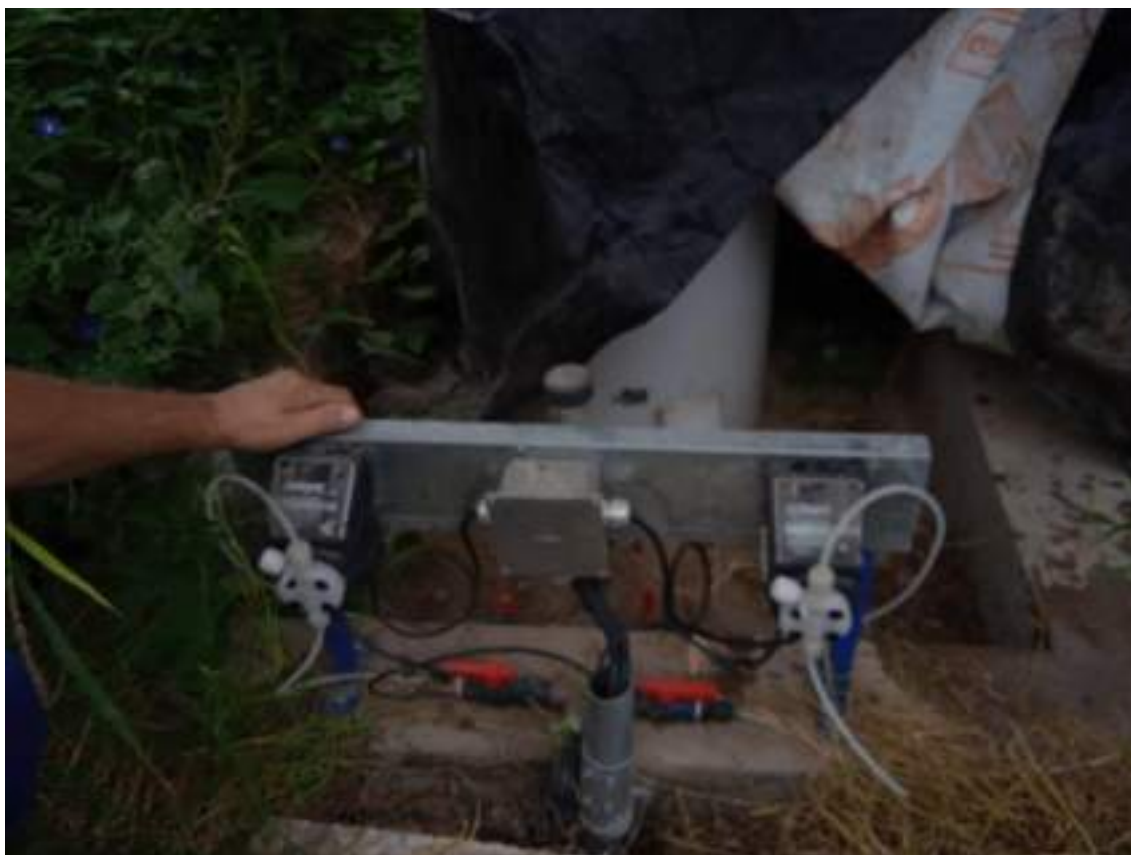
Foto N° 4: Bombas dosificadores de cloro
