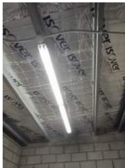
Foto N° 7: Techo sin cielo raso, a ejecutar en PVC – Casa Química
