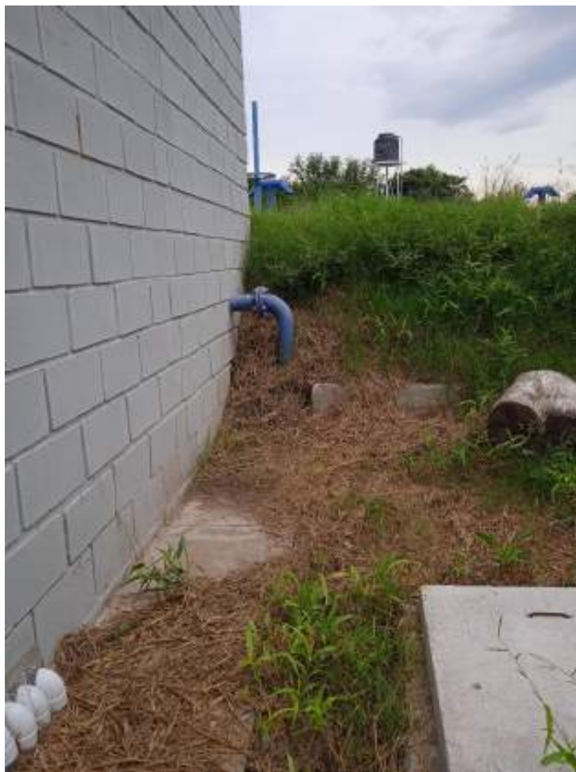
Foto N° 2: Caño de Salida Sala de Bombeo a Sistema de Distribución
