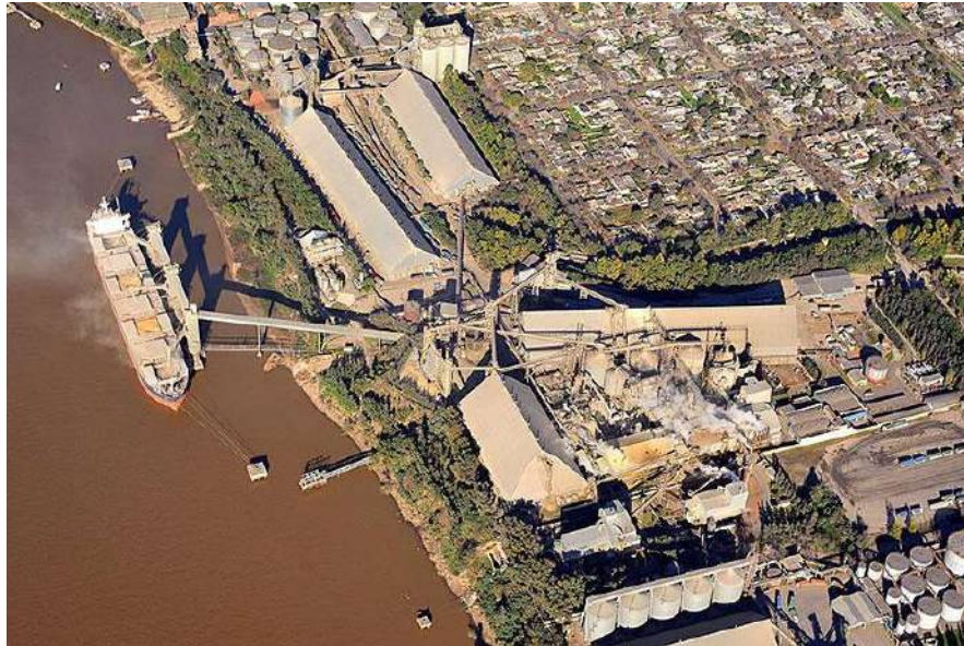
Figura 4. Vista aérea Zona Industrial de Puerto Gral. San Martín
