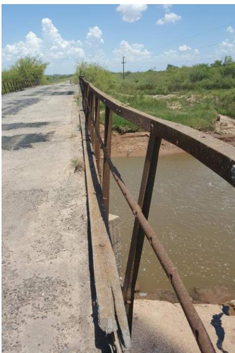
BARANDA METÁLICA SUELTA Y EN MAL ESTADO
