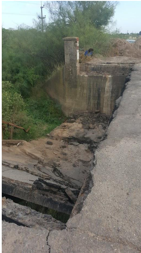
MITAD TABLERO COLAPSADO PRIMER TRAMO LADO NORTE
