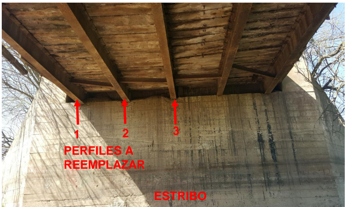
PERFILES METÁLICOS A REEMPLAZAR EN EL PRIMER TRAMO
