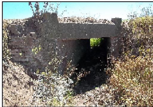
Alcantarilla sobre RP Nº10S (1,6x1,6m)
