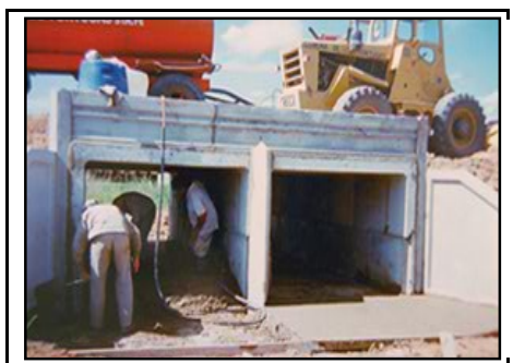
Alcantarilla dos módulos tipo pórtico de hormigón prefabricados.
