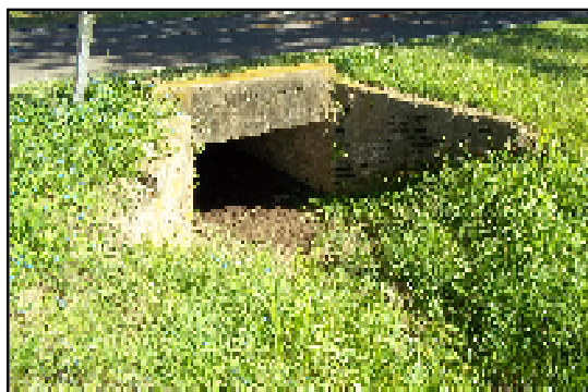
Alcantarilla de Acceso a Peyrano (1,6x 1,1m)
