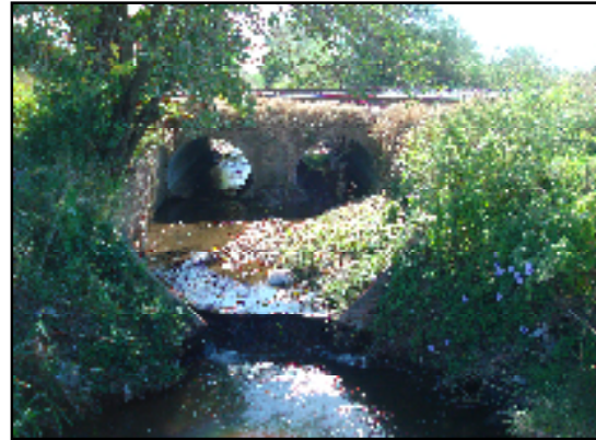
Alcantarilla Nº 6 en FCCC ( \Phi 2,0m)
