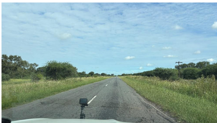
Figura 7. Estado actual del tramo
