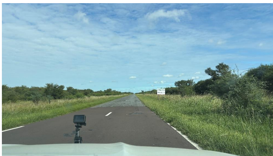
Figura 8. Estado actual del tramo
