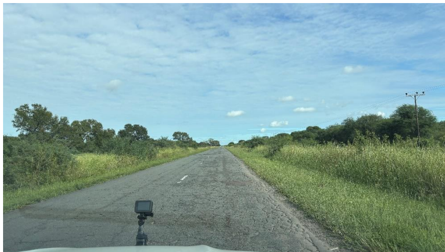
Figura 6. Estado actual del tramo
