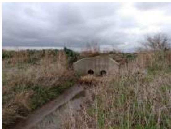
Figura 1 – Alcantarilla bajo FFCC Mitre
