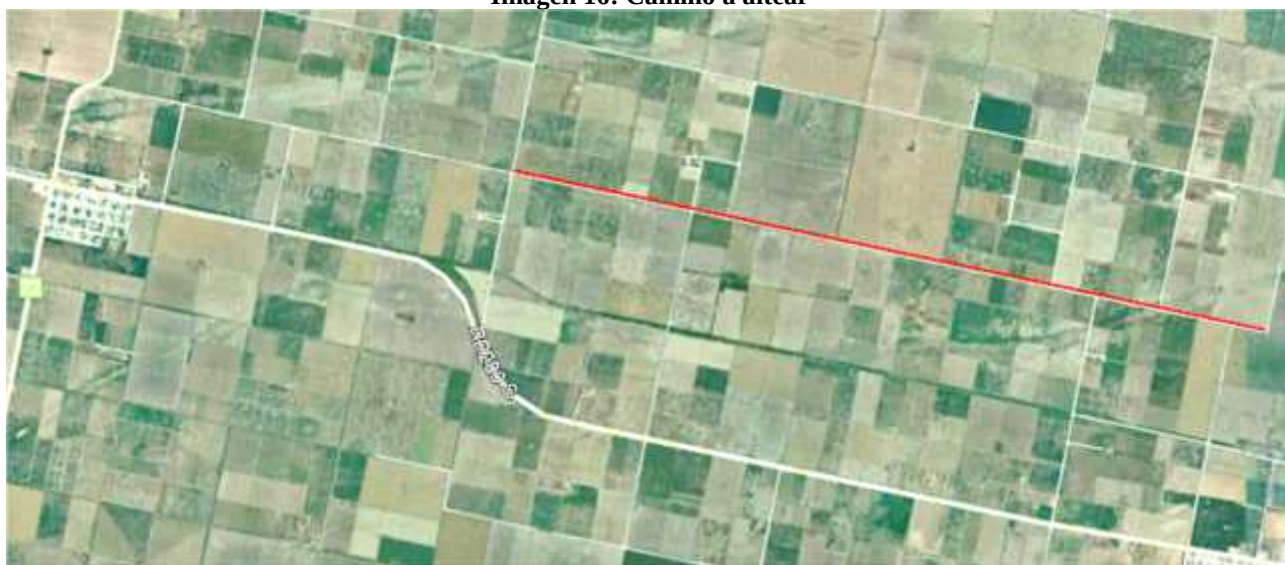
Imagen 17: Camino a altear y compactación ligera
