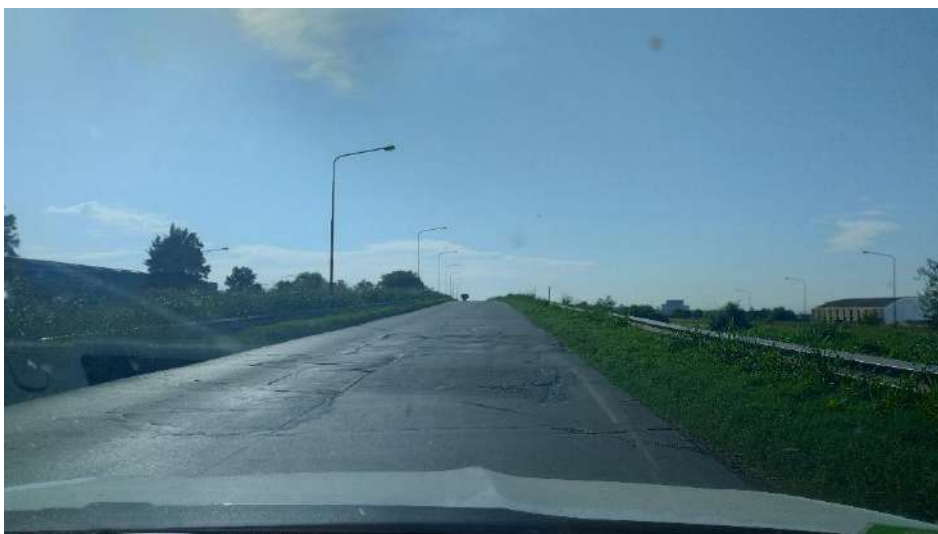
Figura 7. Estado actual R.P. N°21
