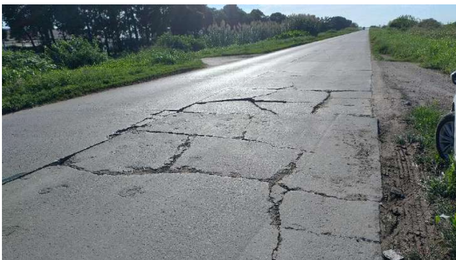
Figura 8. Estado actual R.P. N°21
