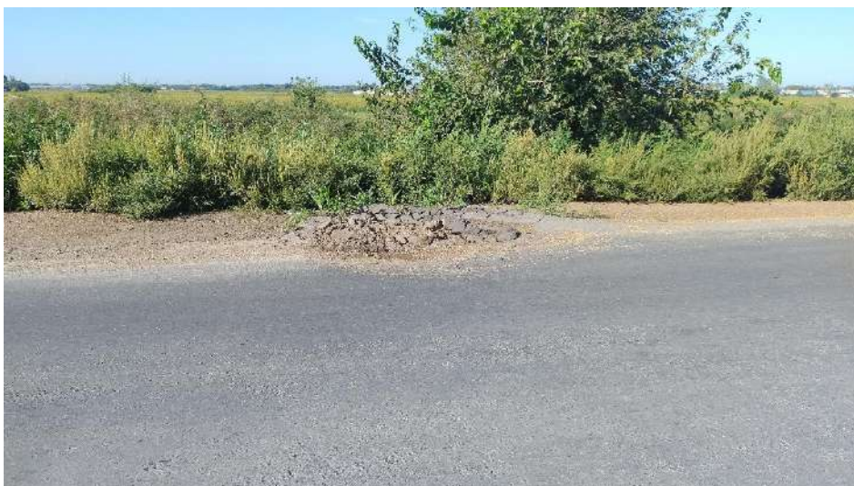
Figura 9. Estado actual R.P. N°21
