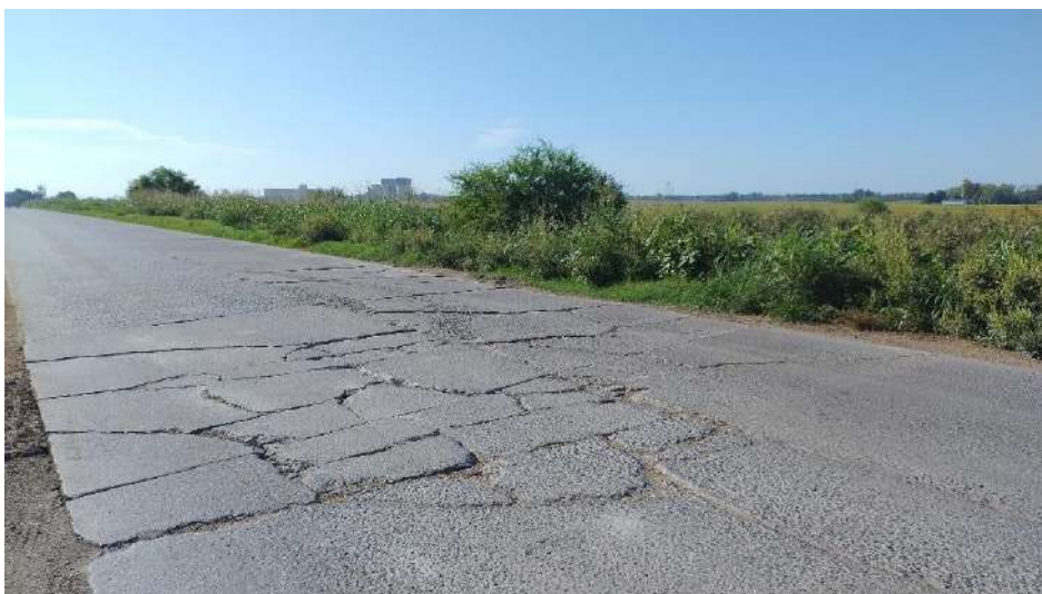
Figura 10. Estado actual R.P. N°21
