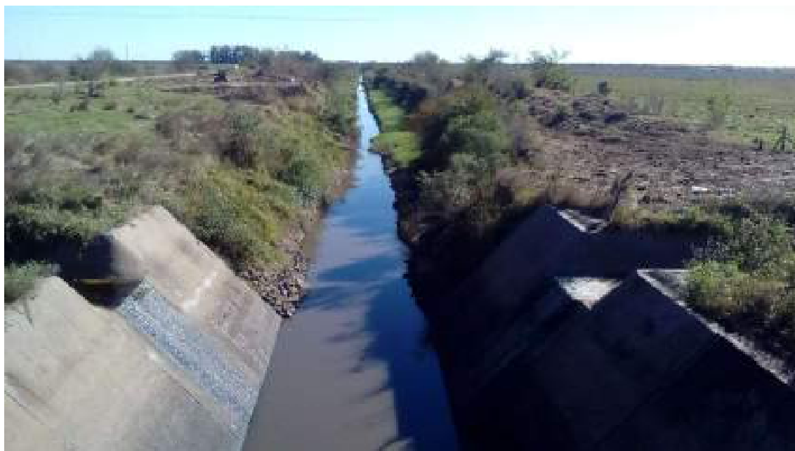
Figura V – Vista Canal Línea Paraná – Tramo I. Aguas arriba RN N° 11 Fuente: CFI 2017.
