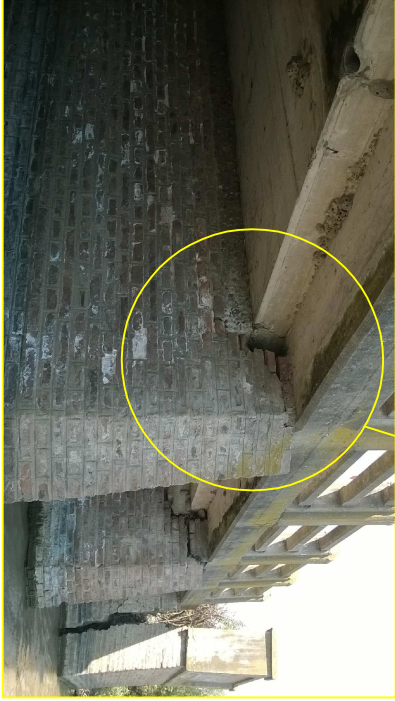
PILA 3: Hundida y quebrada 6 m desde aguas arriba, encontrar y rellenar con H°. Mampostería algo inclinada hacia el Norte. Borde de la losa despegada del encadenado.
