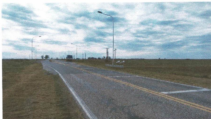
Figura 7. R.P. N°39 – Ahuellamientos y sellado de fisuras
