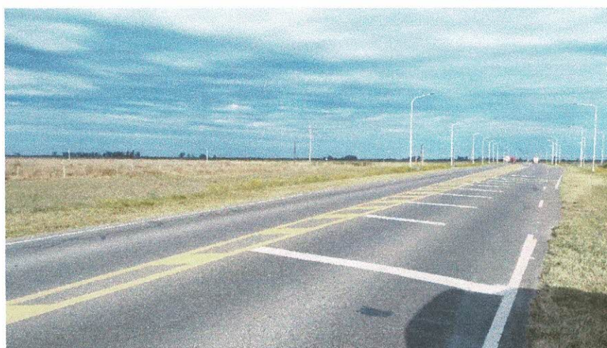
Figura 8. R.P. N°39 - Ahuellamientos
