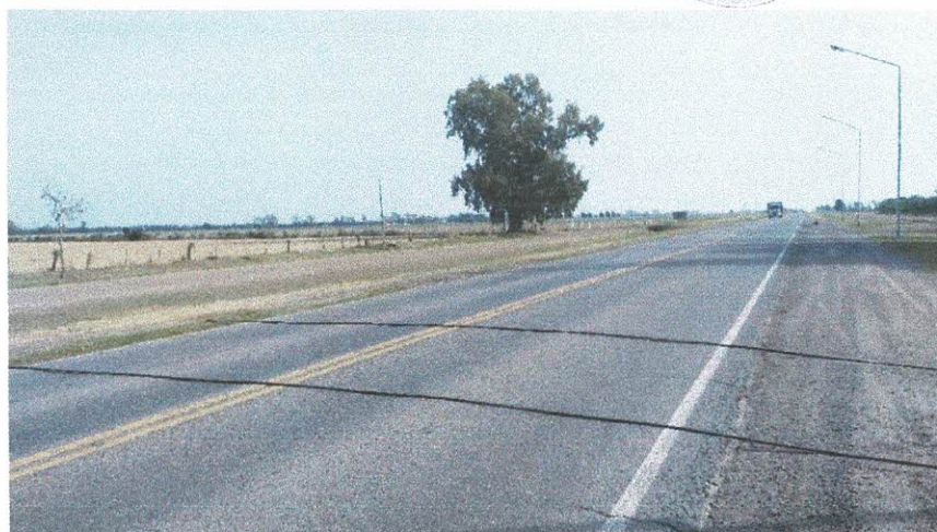
Figura 5. R.P. N°23 – Ahuellamientos
