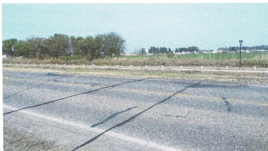
Figura 6. R.P. N°23 – Exudación, ahuellamientos y sellado de fisuras
