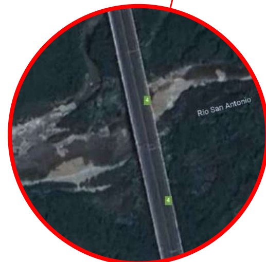
DETALLE ZONA DE PUENTE
