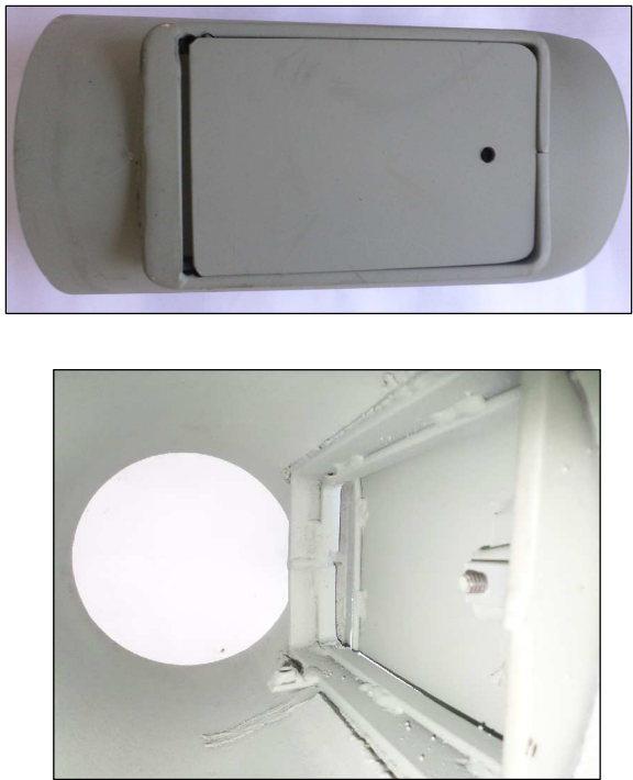
DETALLE 1: Vista externa e interna de la ventana de inspección terminada
