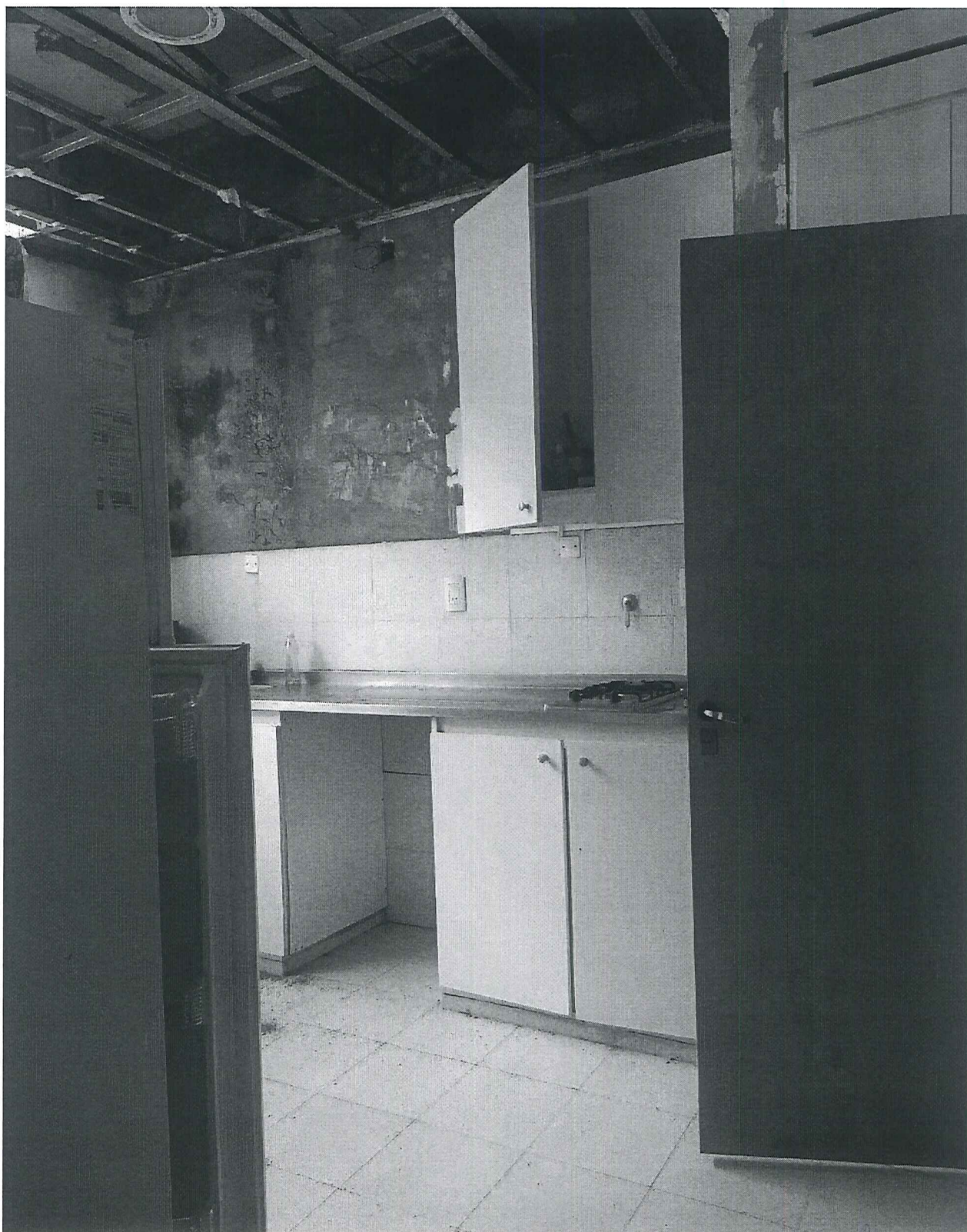
LOCALES INTERIORES. OFFICE
