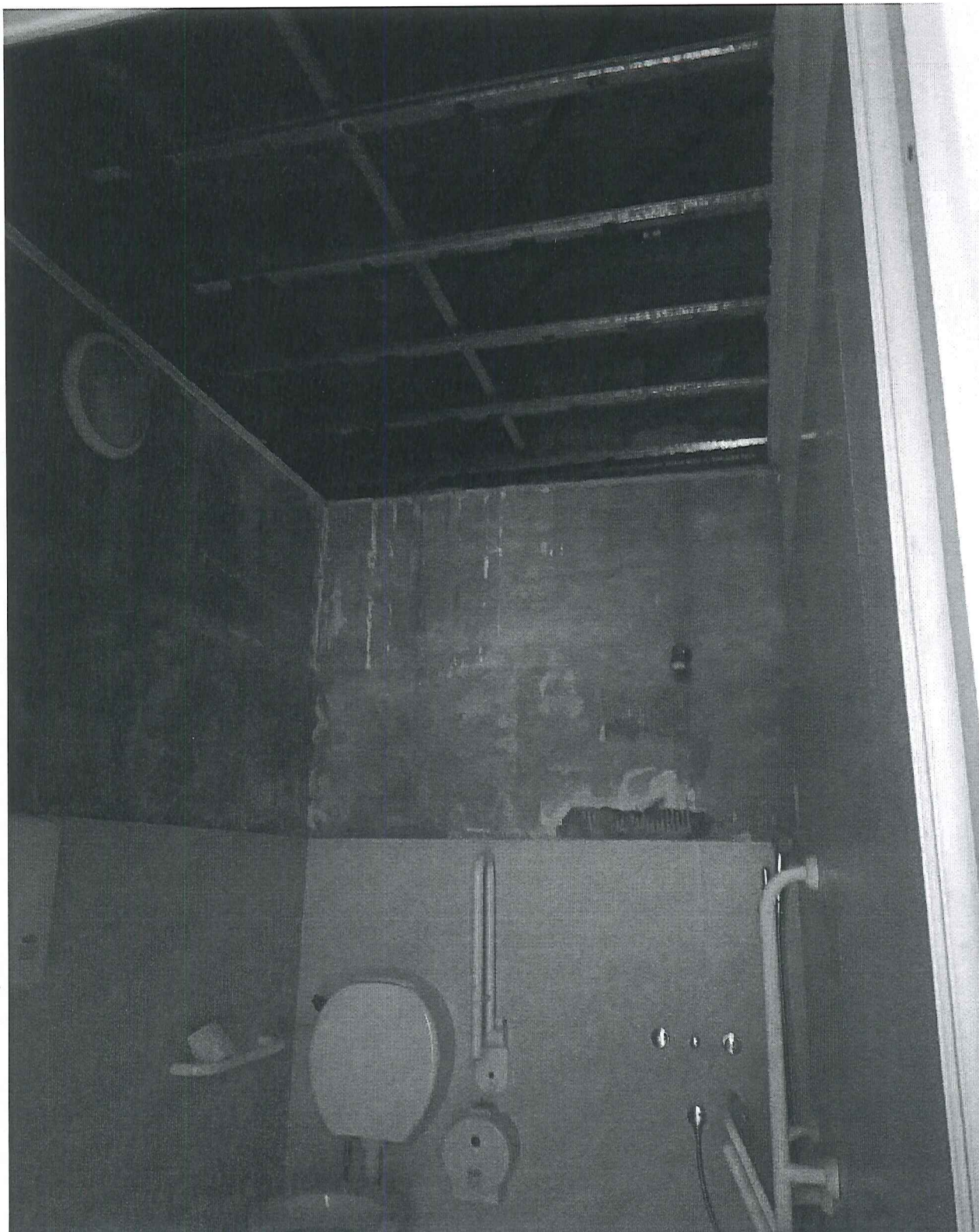
LOCALES INTERIORES: SANITARIO DE ADMINISTRACIÓN
