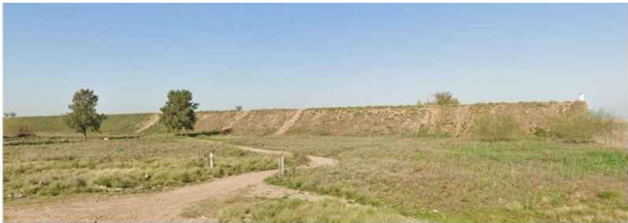
CARCAVAS 1, 2 Y 3 DESLIZAMIENTO 2
