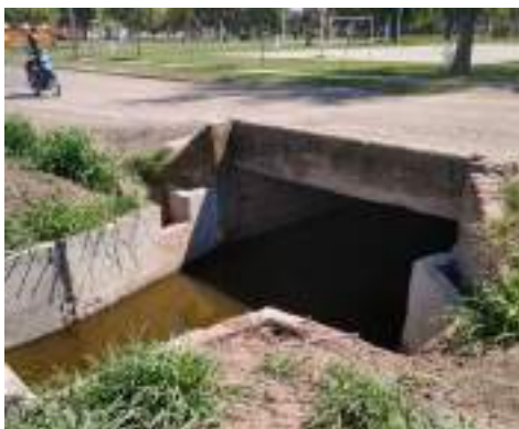
Detalle entubado ejecutado in situ
