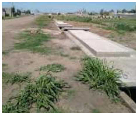
Vista alcantarilla Calle 5 y 4 Modular con alas in situ
