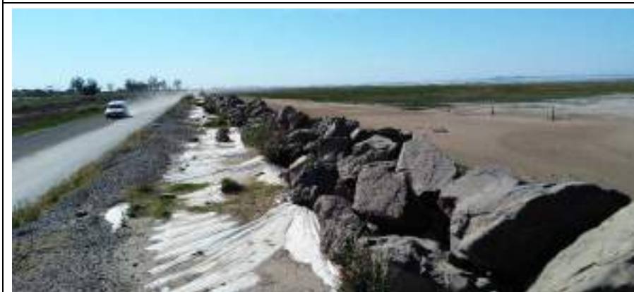
Imagen 2: situación del terraplén precario de bolsas de arena, grava y rocas (agregadas a posteriori para contener el oleaje que se producía por los fuertes vientos) el día 26/09/2019. Ubicación: cruce de Ruta Provincial N° 90 y calle Laprida mirando al este.
