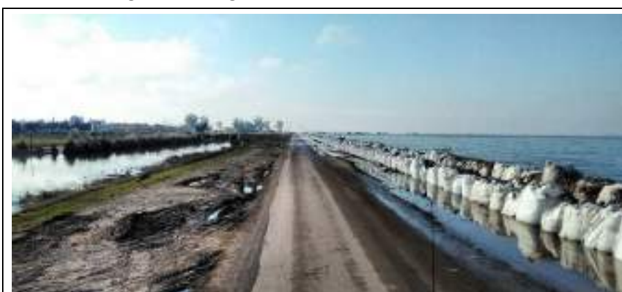
Imagen 1: situación del terraplén precario de bolsas de arena y grava en plena emergencia, el día 31/05/2017. Ubicación: cruce de Ruta Provincial N° 90 s/ Canal Aductor mirando al este.
