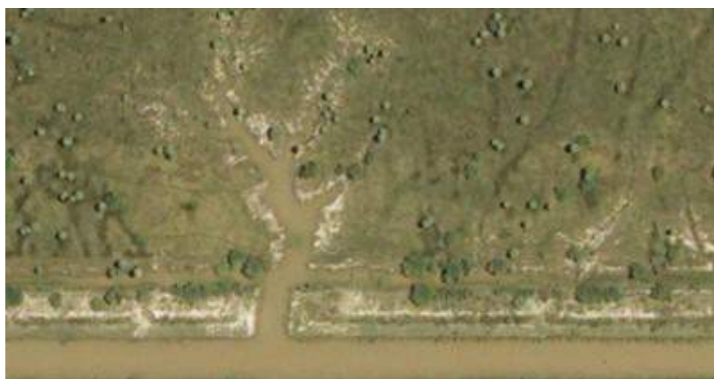
Figura IV – obra de control de erosión sobre la margen izquierda del canal – Tramo II. Fuente: CFI 2017.
