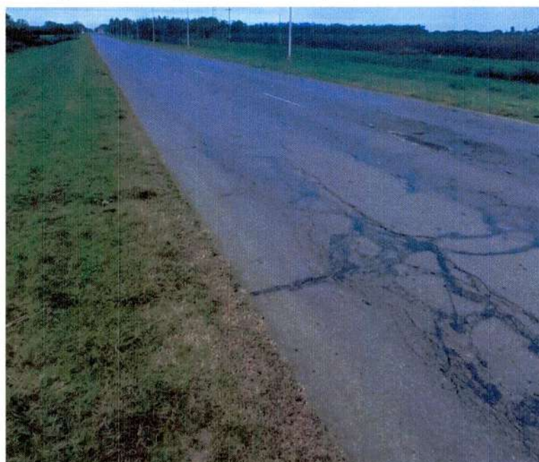
Figura 6. Fisuras y ahuellamientos (Alejandra – Romang)
