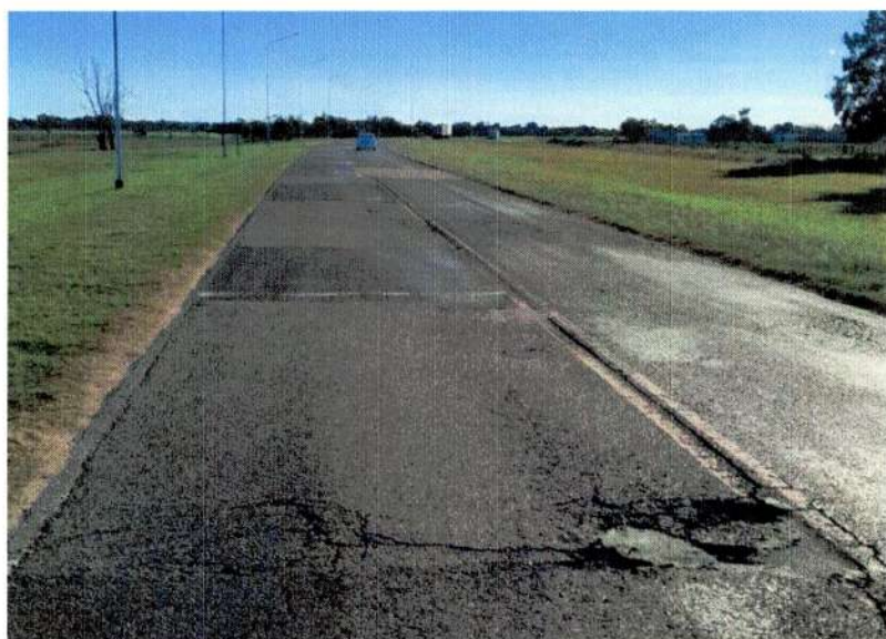
Figura 5. Fisuras y desprendimientos (Alejandra – Romang)
