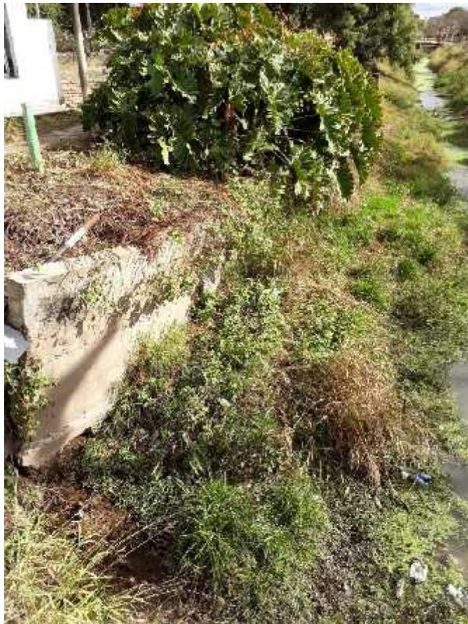
*Imagen 13: Protección existente colapsada sobre Av. Belgrano 10m lineales margen Sur.*
