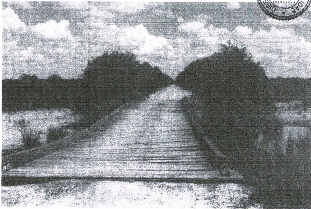
Figura 4. Estado actual estructuras sobre Arroyo El Rey
