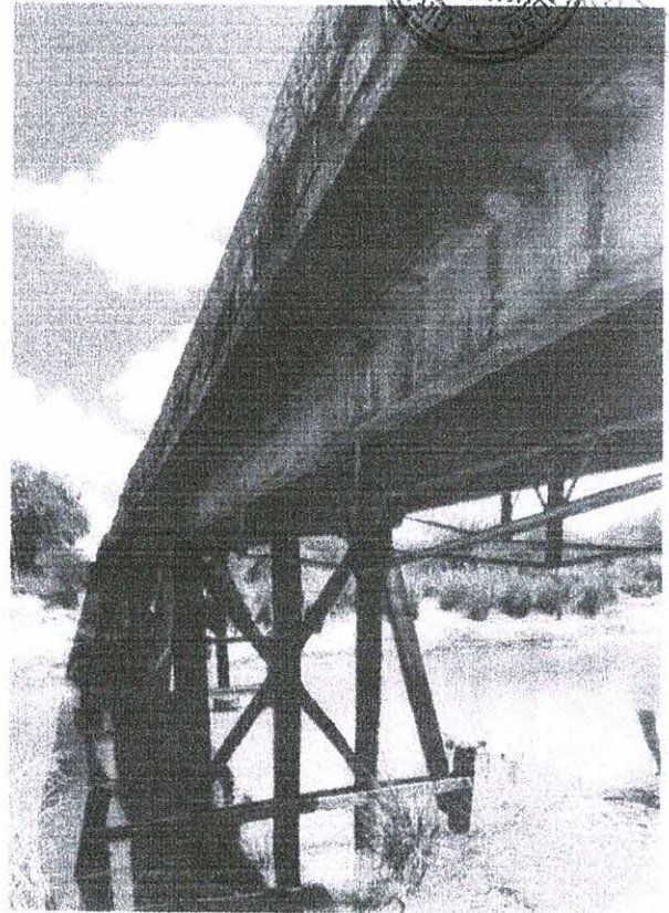
Figura 7. Estado actual estructuras sobre Arroyo El Rey
