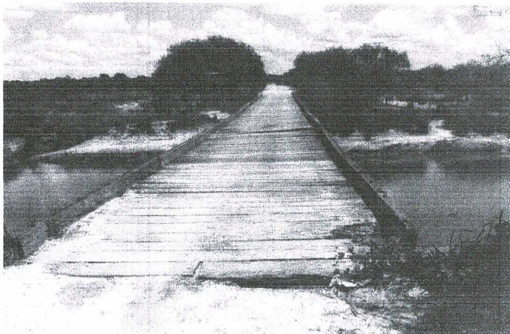
Figura 5. Estado actual estructuras sobre Arroyo El Rey
