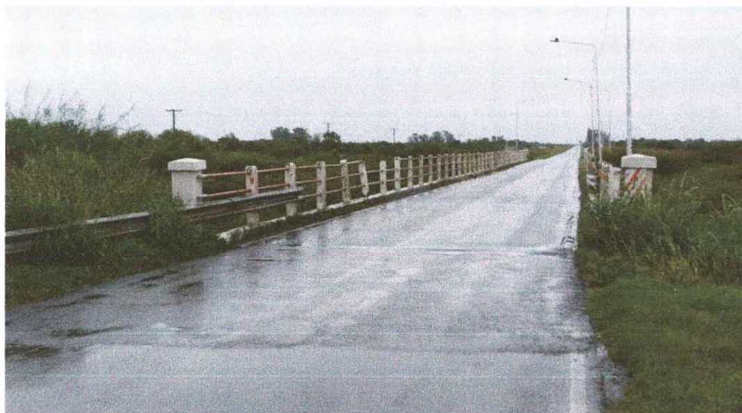
Figura 6. Puente sobre Arroyo San Antonio
