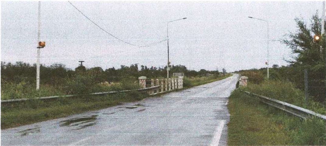
Figura 5. Puente sobre Arroyo Capivara II
