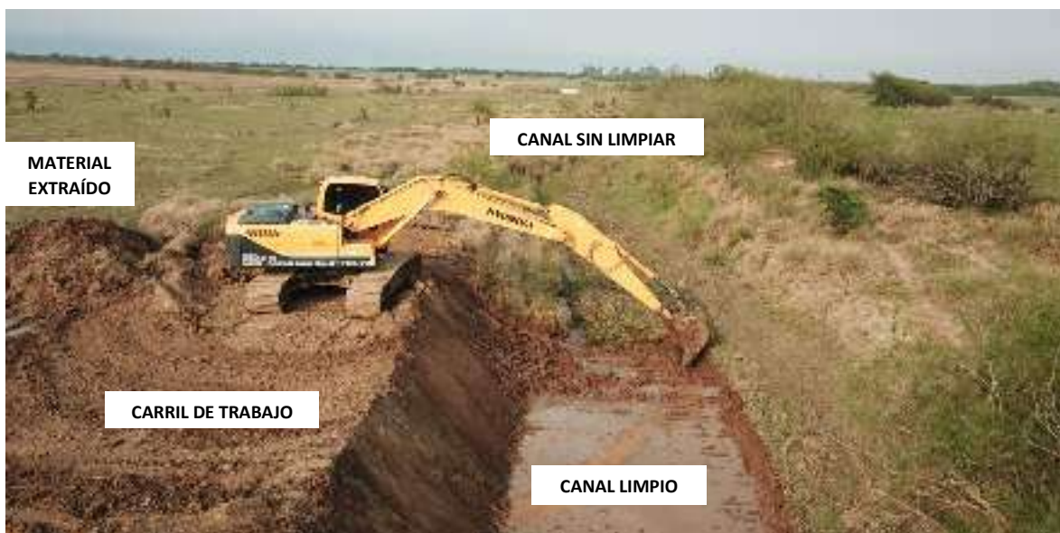
Limpieza de un canal secundario e identificación de carril de trabajo.
