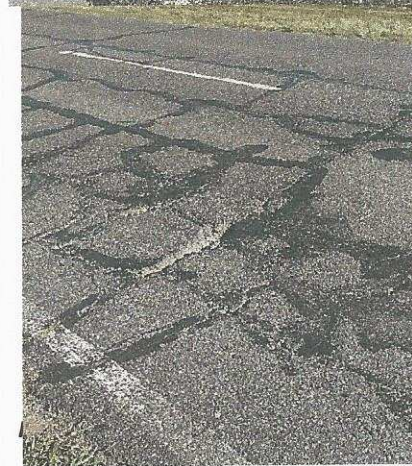
Figura 3. Desprendimientos y fisuras longitudinales.
